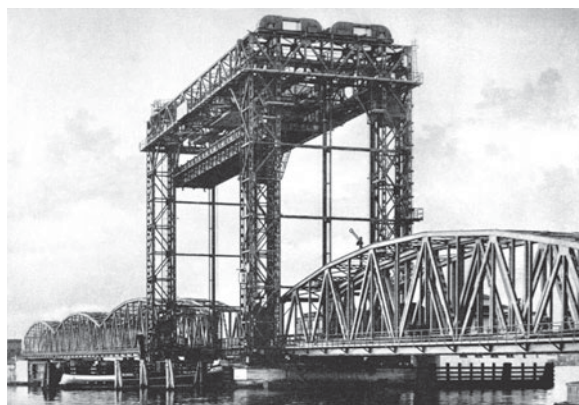
In Karnin entstand diese gewaltige Hubbrücke 1934.
