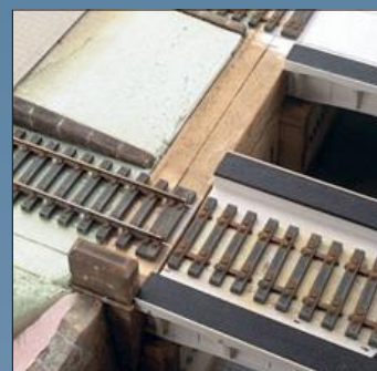
Damit die Brücke herausnehmbar bleibt, sind exakte Trennungen der Gleise notwendig.
