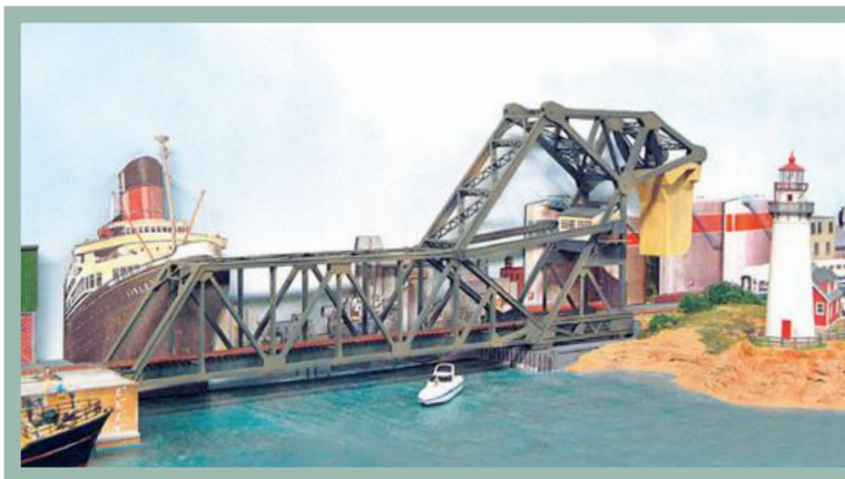
Weit ausladende Fachwerk-Klappbrücken benötigen ein großes Gegengewicht. Diese Bauart ist jedoch amerikanisch.
