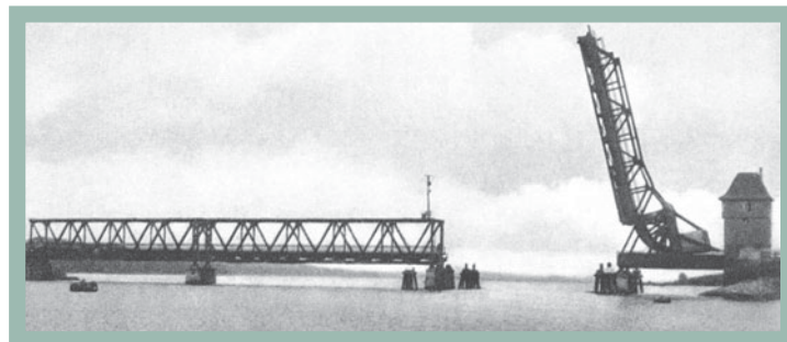
Weit ausladende Fachwerk-Klappbrücken benötigen ein großes Gegengewicht. Diese Bauart ist jedoch amerikanisch.
