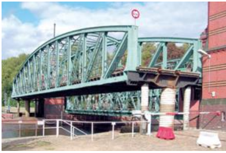
Im Hafen von Lübeck errichtete man 1900 zwei Hubbrücken, die in erster Linie mit Wasserdruck, aber auch mit Elektromotoren betrieben wurden. Sie stehen noch heute dort.
