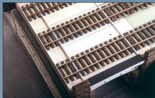
Die beim Vorbild üblichen Trennbleche zum Zurückhalten des Schotters zwischen Bahndamm und Brücke entstehen aus passenden Profilen.
