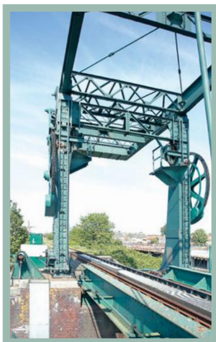
1928/29 errichtete man nahe Medemblik in den Niederlanden eine Kranbrücke an der Schleuse zur Hafeneinfahrt. Sie war noch komplett genietet worden. Sie ist heute restauriert.
