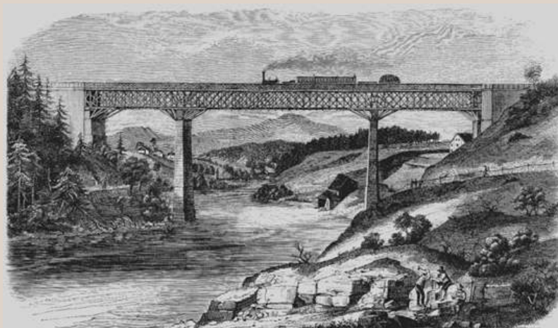
Eine Meisterleistung im Holzbrückenbau ist die 1850 nach dem System Howe gefertigte Brücke bei Kempten. Sie wird heute nur noch von Fußgängern benutzt.
