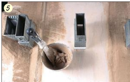
Die platzierten Köpfe werden in die sie umgebende Landschaft eingipst.
