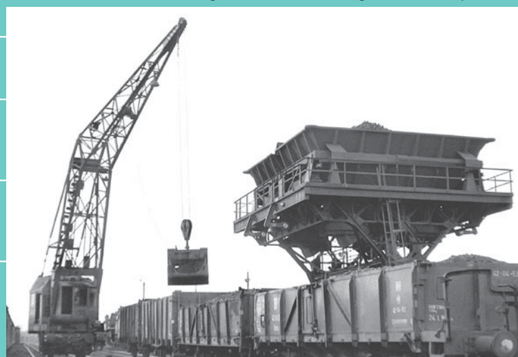
Schon vor dem Zweiten Weltkrieg baute Ardelt die ersten Hochbunker. Den Erfurter Bunker mit schrägen Taschen füllten Regel- oder Breitspurkran.
