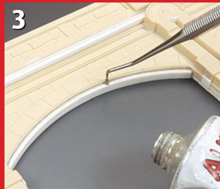
Lücken und kleine Spalten werden mit aufgetragener Spachtelmasse verschlossen.
