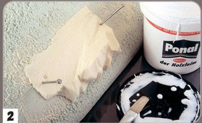
2 Die einzelnen Felsstücke werden am Hang verklebt. Zum Fixieren dienen Nägel, die nach Aushärten des Leims entfernt werden.
