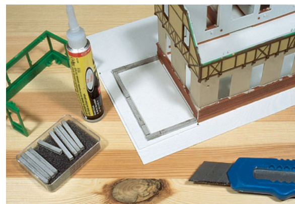
Das Fundament des Anbaus entsteht aus Weinert-Weißmetallteilen, die eigentlich Zaunkanten sind.
