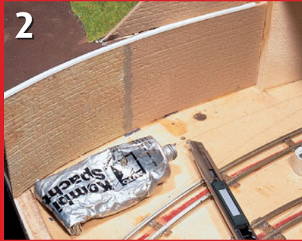
2 Trennkanten zwischen einzelnen Platten verfüllt man mit Nitro-Kunststoffspachtel.
