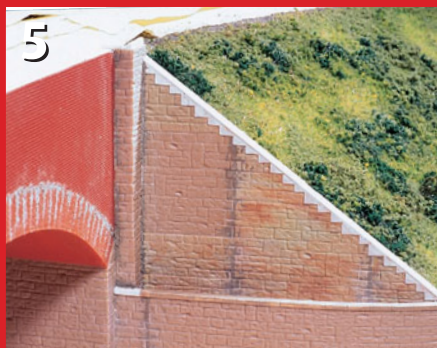
5 Treppenförmig schließen die Abdeckplatten zum Schutz der Stützmauern die Kante.
