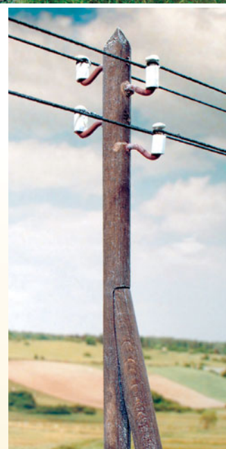
Die Isolatoren entstehen aus lackierten Nägeln und passend abgesägten Kunststoffrohren.
