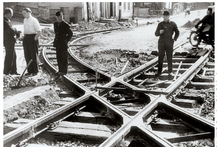
Um 1950 wurde diese Kreuzung neu verlegt. Die Eisenbahn kreuzt hier die städtische Straßenbahnstrecke.
