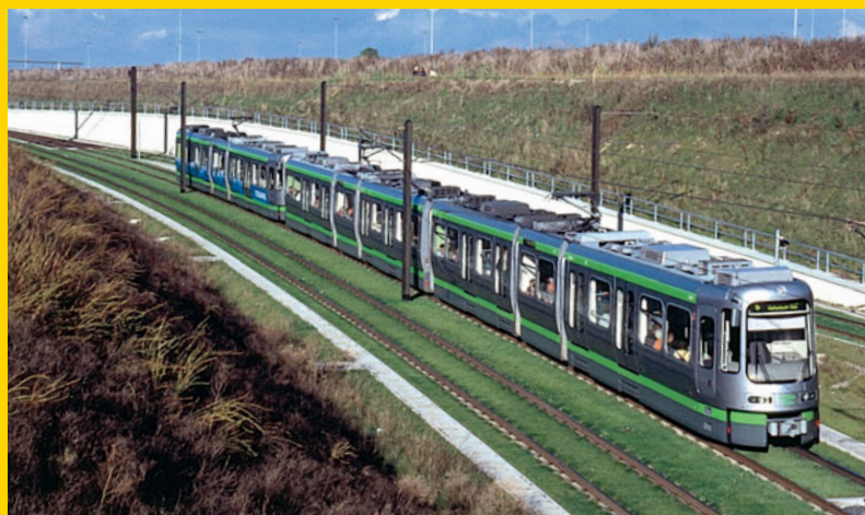
Teilweise in der neuen Rasen-Gleistechnik gebaut wurde die Verbindungsstrecke, die Hannover mit dem Messegelände verknüpft.
