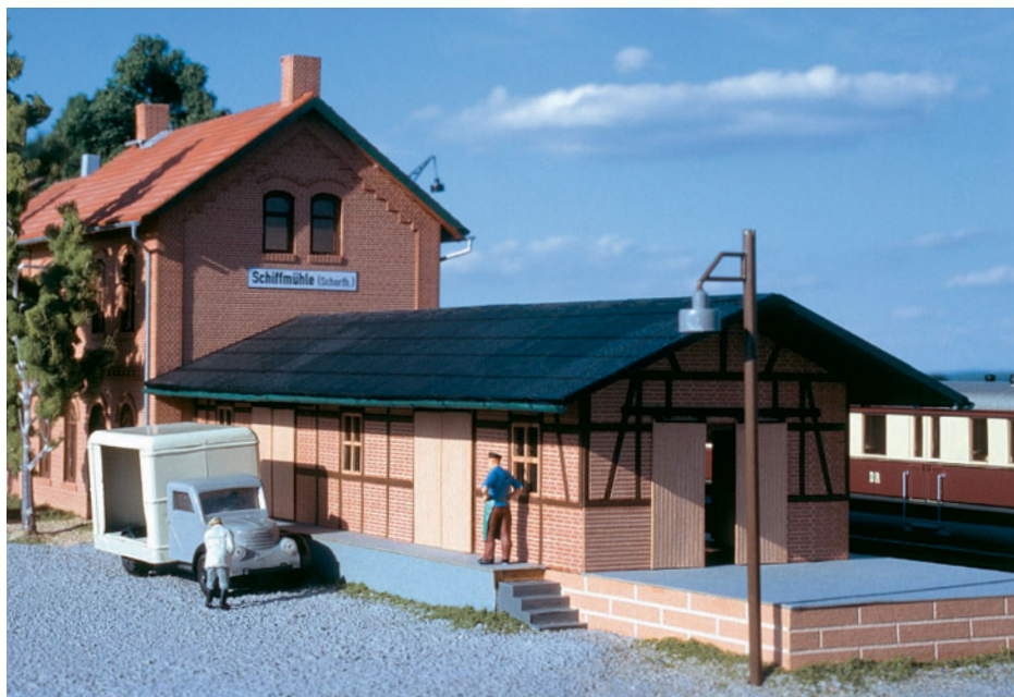
Für den Güterumschlag auf einer Nebenstrecke genügte der kleine Fachwerkschuppen.
