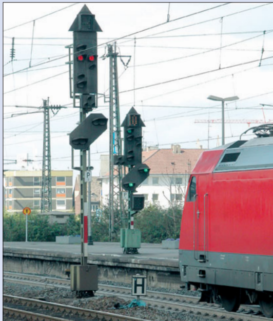
Alles an einem Mast: Moderne Lichtsignale als Haupt- und Vorsignalkombination stehen in Essen Hbf. Auch hier gibt es wieder verkürzte Ausführungen. Interessant ist die unterschiedliche Anordnung des Ersatzsignals Zs 1.
