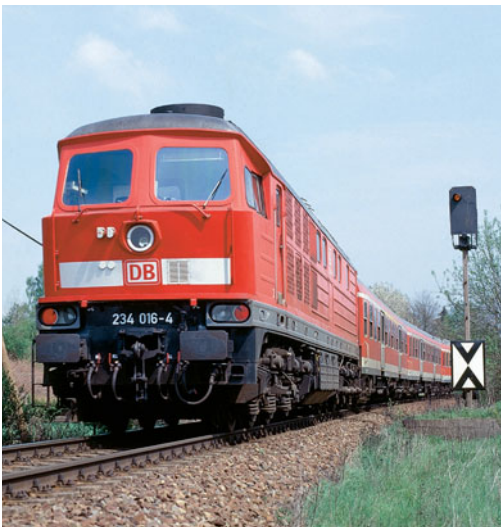
Aus Ersparnisgründen verfügt der Signalschirm nur über eine Lampe, da nur ein Signalbegriff (HI 10) angezeigt wird.
