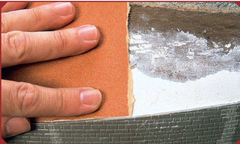
Mit einem zur besseren Haftung der Finger gefalteten Schleifpapier kann man Gipsoberflächen beim Landschaftsbau gestalten.
