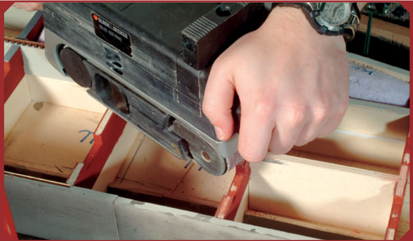
Für größere Schleifarbeiten beim Anlagenbau kann ein Bandschleifer zum Einsatz gelangen. Zu grobes Schleiffeinen trägt aber zu viel Material ab.
