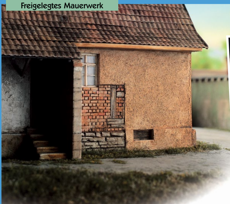
An einer der Hauswände war früher ein Brotbackofen angebaut. Nach seinem Abriss kommt das ursprüngliche Mauerwerk zum Vorschein.
