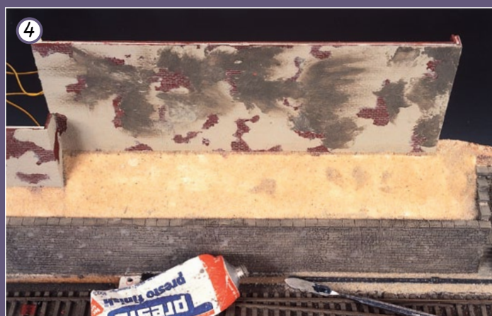
Noch vorhandene Unebenheiten in der gespachtelten Oberfläche werden durch einen weiteren Spachtelauftrag beseitigt.
