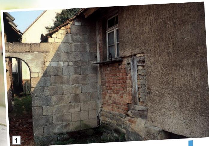
An einer der Hauswände war früher ein Brotbackofen angebaut. Nach seinem Abriss kommt das ursprüngliche Mauerwerk zum Vorschein.
