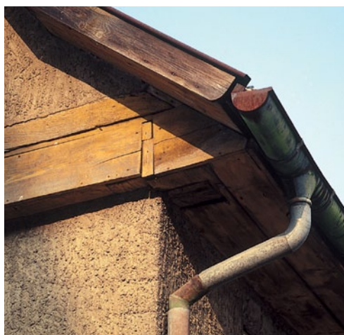
Die Verkleidung der einzelnen Sparren zum Dachkasten erfolgt beim Vorbild mit einfachen Brettern. Sie setzt sich am Giebel fort.
