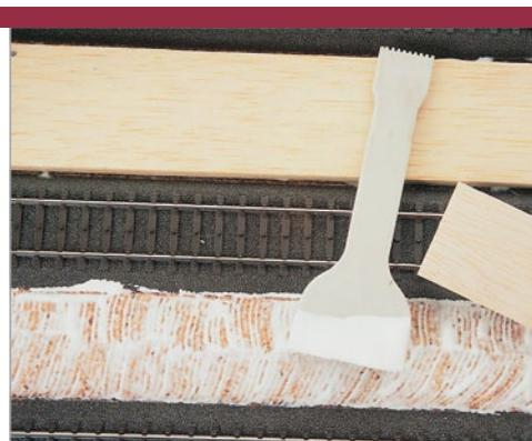
● Die fertige Schwellenbettung vom Märklin-C-Gleis kann man mit Pulverfarben einfärben.
