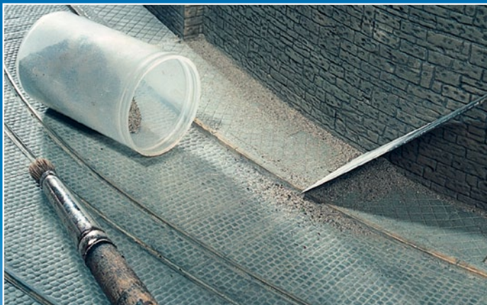
7 Mit einem Sand-Drainagegemisch verfüllt man den Randstreifen. Danach glättet man ihn mit einem Spachtel.
