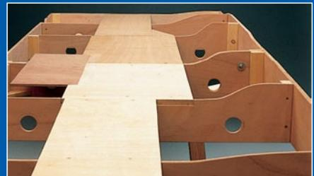
Die Gleistrasse ruht auf stabilen, senkrecht stehenden Sperrholzspanten.
