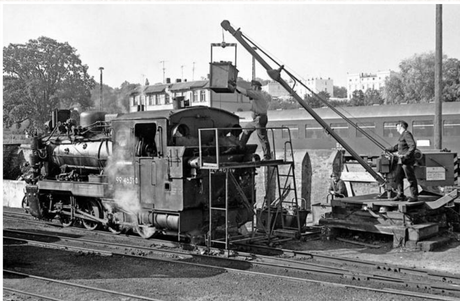
Die Deutsche Reichsbahn erleichterte ihren Personalen die Bekohlungsarbeit, als sie Anfang der 1960er-Jahre im Lokbahnhof Putbus einen elektrischen Kran installierte.
