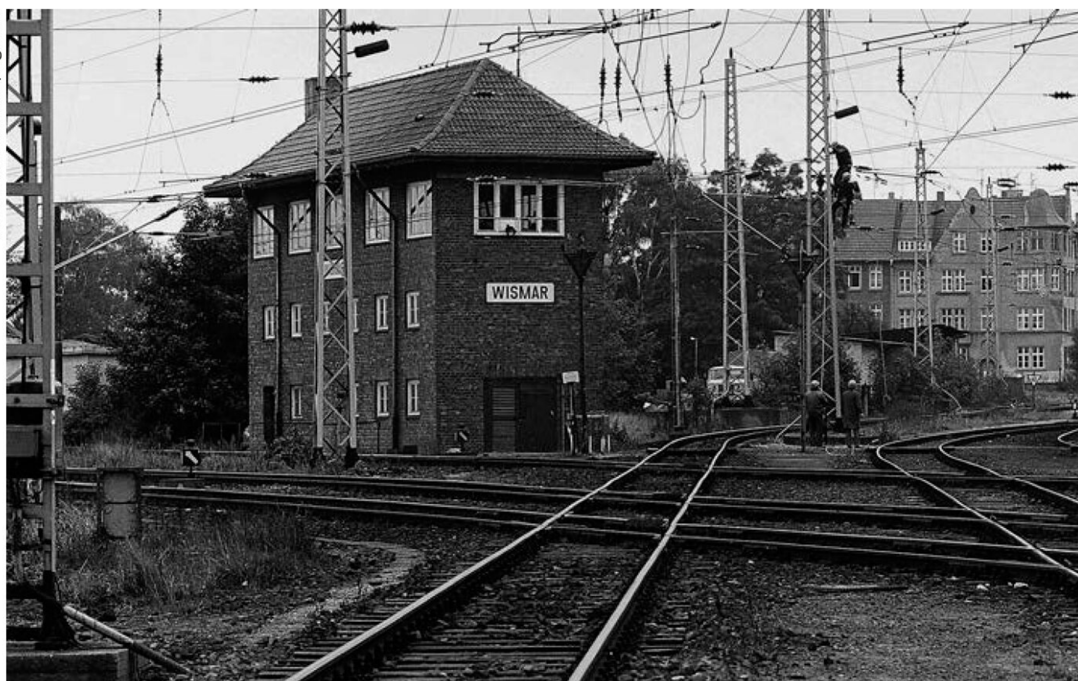
Die Ausfahrgleise des Bahnhofs Wismar in Richtung Rostock (links) und nach Schwerin (rechts) zeigen ein Problem von historischer Tragweite: gedrängte Bahnhofsanlagen mit großen Kreuzungswinkeln auf städtebaulich denkbar ungünstigem Terrain.
