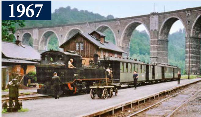
99 535 ist aus Eppendorf in Hetzdorf (Flöhatal) eingetroffen. Dort bestand Anschluss zur normalspurigen Bahnstrecke.
