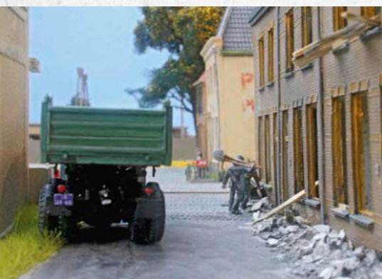
Die alten Häuser der Hafenstraße 12 bis 18 werden abgerissen. Wer weiß, was hier später entstehen wird?
