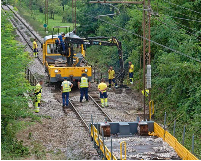
Sturzfluten beschädigten am 29. August 2025 die Koper-Rampe bei Rizana stark. Innerhalb Stunden ist der Schaden repariert.
