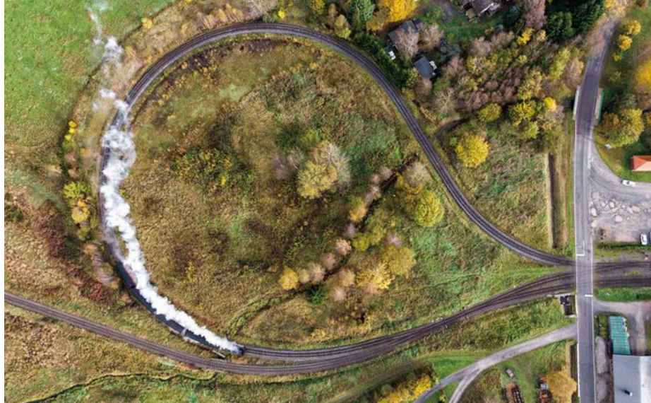
Die vor 40 Jahren am Bahnhof Stiege der Selketalbahn im Harz angelegte Wendeschleife durchfuhr am 18. Oktober 2014 der von der 99 5906 gezogene N8951.
