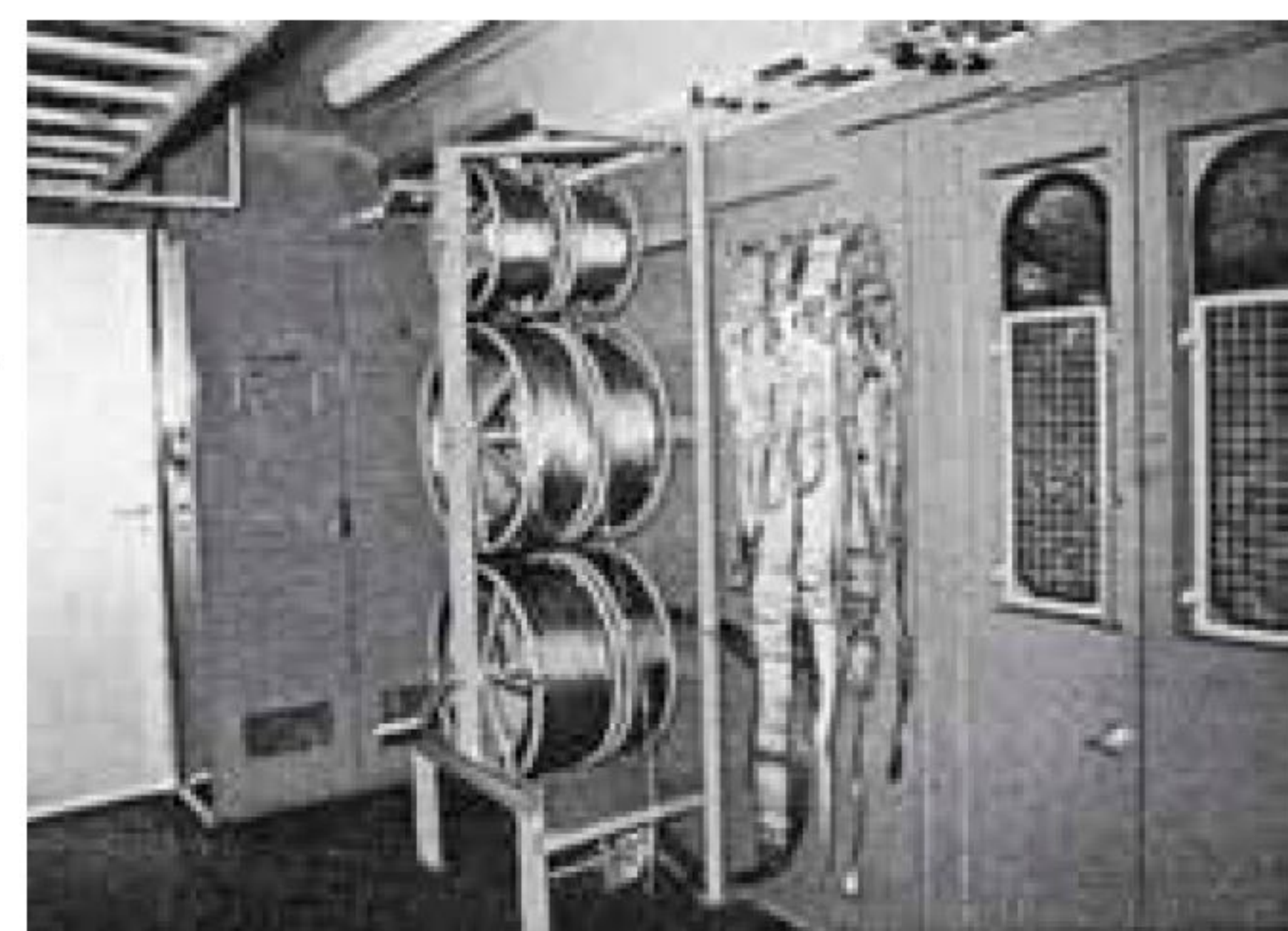
Auf den qualitativ leider nicht herausragenden Repros einer DB-Broschüre zum Turmtriebwagen der Baureihe 704 sind die Werkstatt (links) und der Seilraum (rechts) zu sehen.
