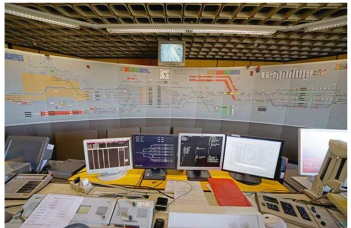
Auch ein Prozessrechner vom Typ Siemens R30 mit einer aktiven Gleisplan-Schaltwand befindet sich im Fahrdienstleiter-Stellwerk des Rangierbahnhofs. Für 2026 ist ein neuer Computer geplant.
