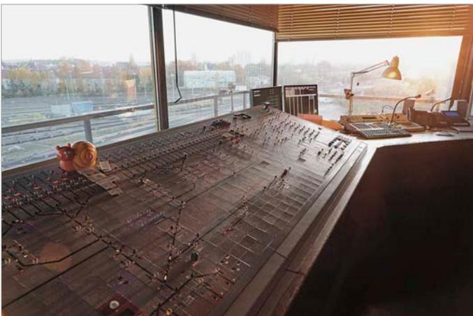
In seinem Inneren ist ein Spurplan-Drucktastenstellwerk der Bauform S 600 verbaut. Die Kanzel gewährt einen freien Blick auf den Ablaufberg, die Gleisbremsen und die Richtungsgleise.
