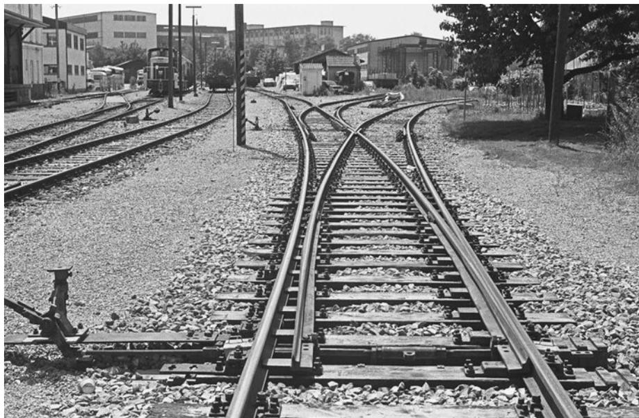
Diese beiden Aufnahmen dokumentieren das Verschwinden der Doppelweichen selbst aus untergeordneten Gleisen (Bhf. Weingarten 1987 und 1989). Man sieht, dass einiger Aufwand nötig war, um diesen Austausch zu ermöglichen.
