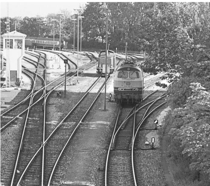
Seltener sind die einseitigen Doppelweichen. Diese hier lag in Lindau. Spätestens mit den Modernisierungsarbeiten auf dem Bodensedamm wurde sie durch einfache Weichen ersetzt.
