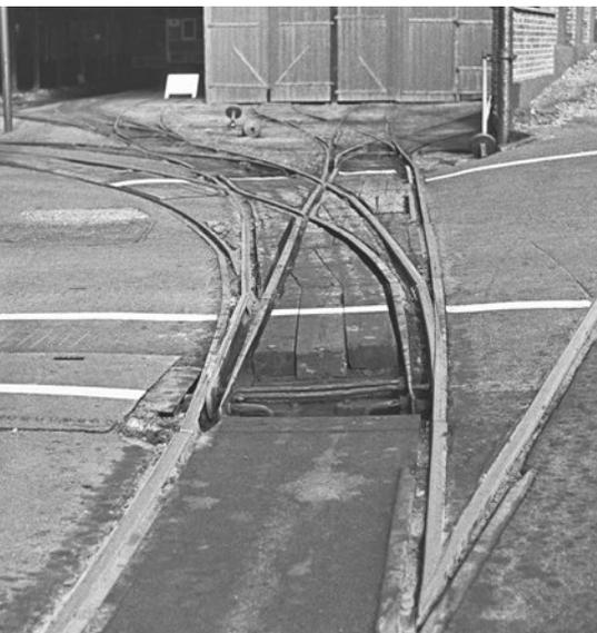
Bei dieser Doppelweiche im Betriebsbahnhof der Manx Electric Railway zweigen zwei Gleise mit verschiedenen Radien zur selben Seite ab! (26. August 1984)
