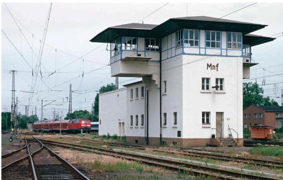
Das Fahrdienstleiter-Stellwerk „Mnf“, ein elektromechanisches Einreihen-Hebelwerk, lag am nördlichen Ende der Bahnsteige. Es ging 2003 außer Betrieb und wurde abgerissen.
