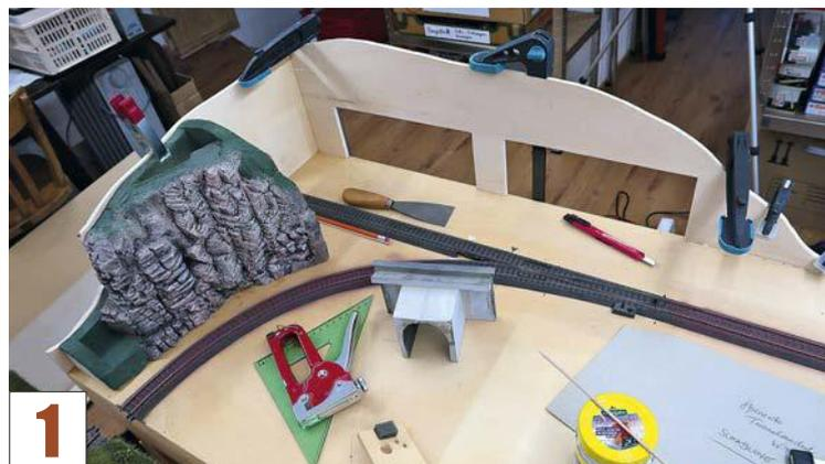
Der Weiterbau beginnt mit dem Zuschnitt und der Aufstellung des äußeren Landschaftsprofils aus 8 mm dickem Pappelsperholz
