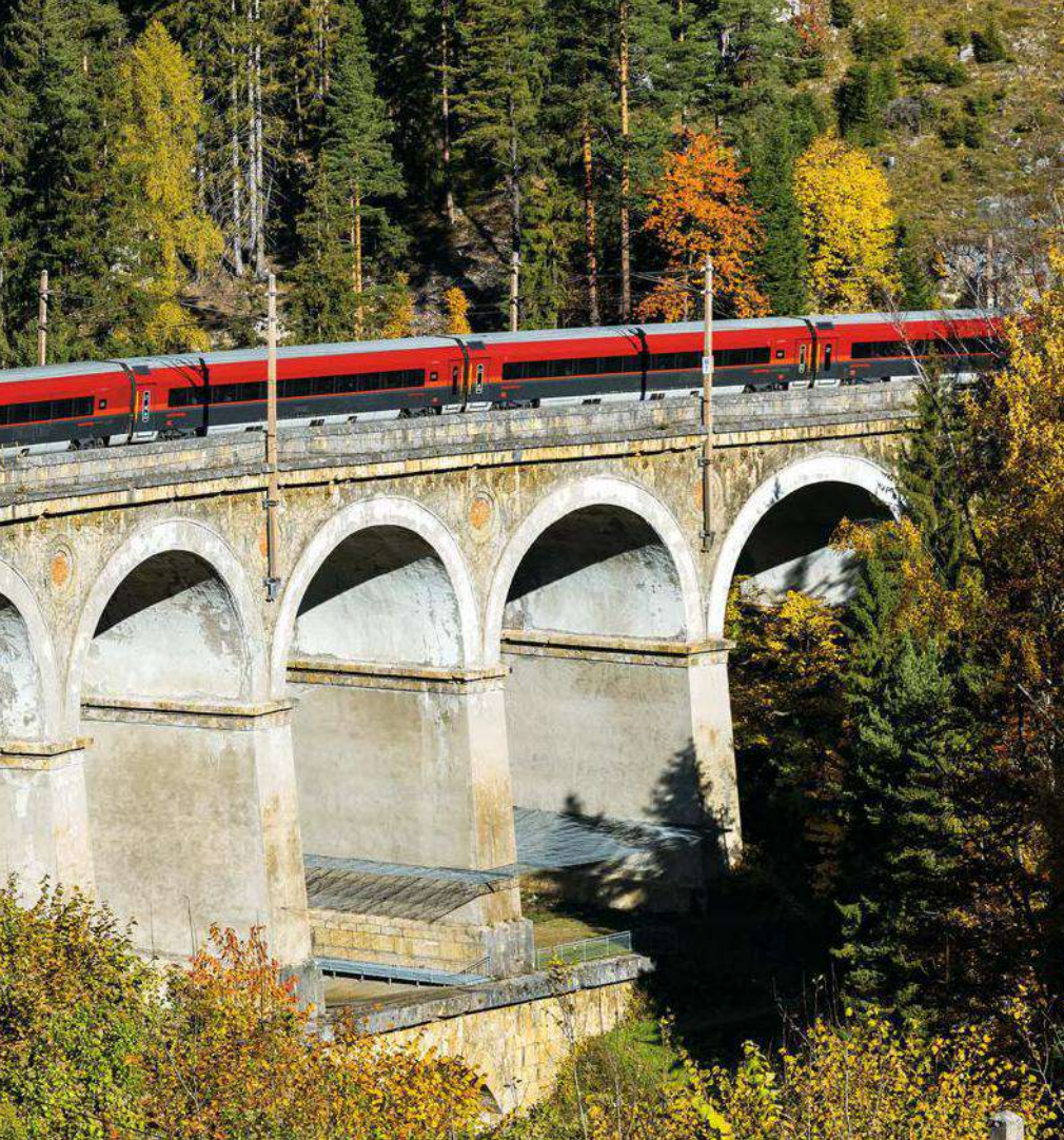
Der Siemens-„Taurus“ (ES64-U2) 1116 250 der ÖBB zieht den RailJet RJ559 von Wien Flughafen nach Graz über den 184 Meter langen und 46 Meter hohen „Kalte Rinne“-Viadukt. Der Bogenradius beträgt hier nur 190 Meter.
