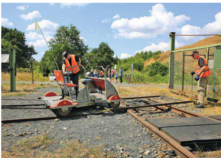
Auf dem Bergwerksgelände werden die Draisinen an den Betriebstagen ins Gleis gesetzt.
