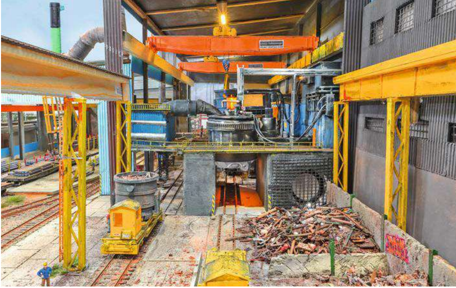
Im Siemens-Martin-Ofen wird hauptsächlich aus Stahlschrott wieder flüssiger Stahl hergestellt. Als nötige Zugaben kommen noch Roheisen und unterschiedliche Zuschläge dazu.
