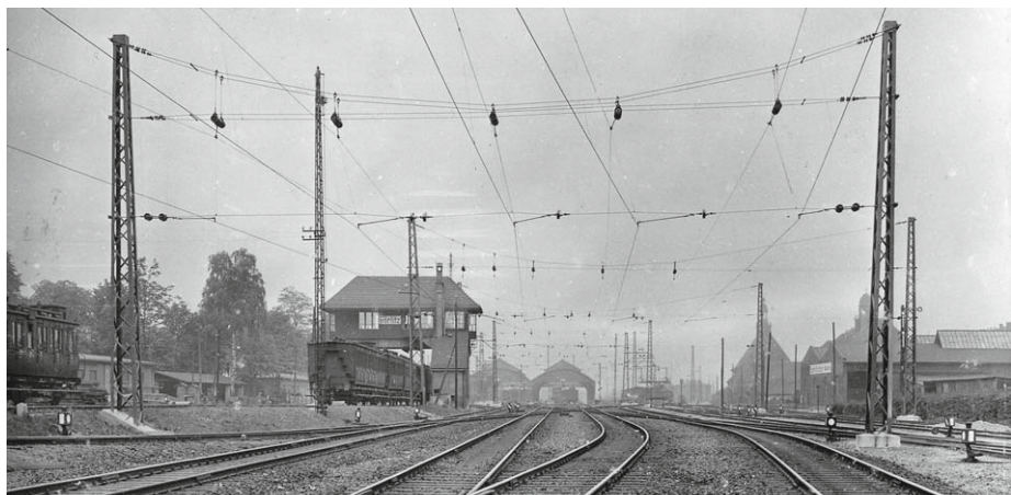
Mitte der 1920er-Jahre zeigt sich der Ostkopf des Bahnhofs Görlitz unter Fahrdrabt. 1923 wurde er westlicher Endpunkt des schlesischen E-Netzes. Links das Reiterstellwerk „Got“.
