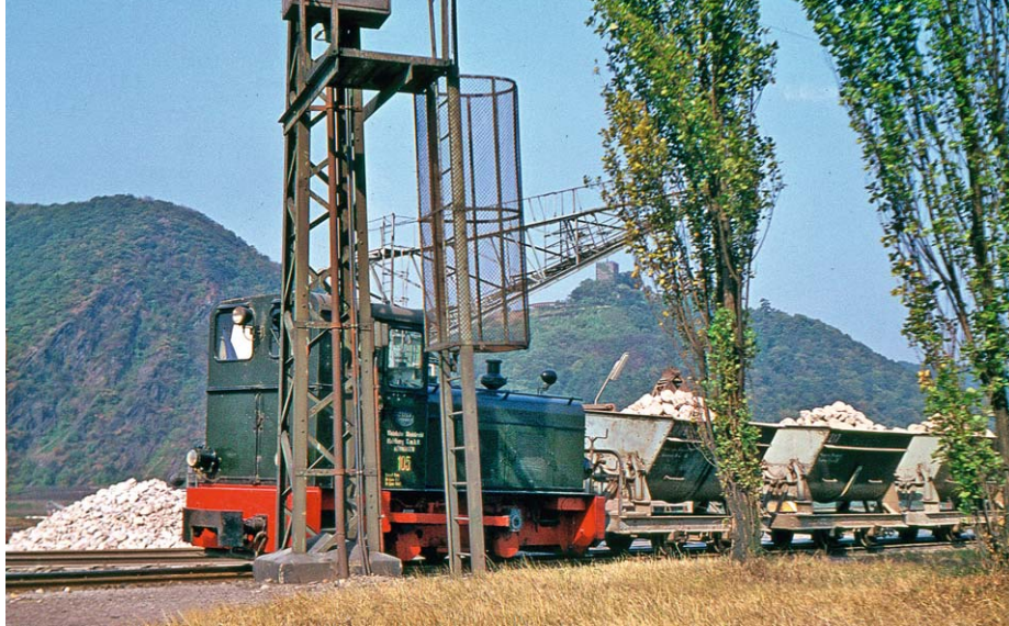
Am Umladeplatz in Rheinbrohl: Der hinter der Lok 105 sichtbare Kran im Hafen hat einen aus sechs Kipploren bestehenden Zug mit Rohphosphat beladen.
