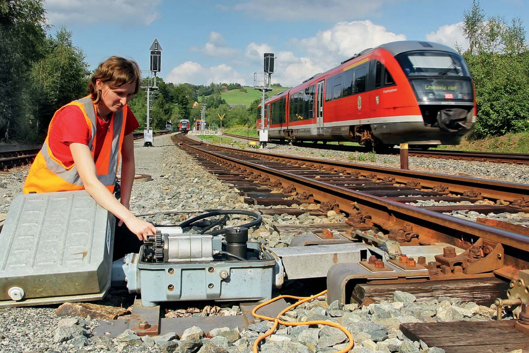
In Annaberg-Buchholz Süd ist hier der Kasten des elektrischen Antriebs der Weiche W 03 für die Kontrolle und das eventuelle Nachschmieren von beweglichen Teilen der Kraftübertragung geöffnet worden.
