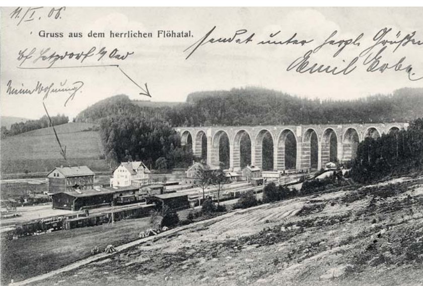
Der Hetzdorfer Viadukt ist seit mehreren Jahrzehnten vom Schienenweg abgeschnitten. Auch der Bahnhof zu seinen Füßen ist zu einer dreigleisigen Anlage zurückgebaut worden.
