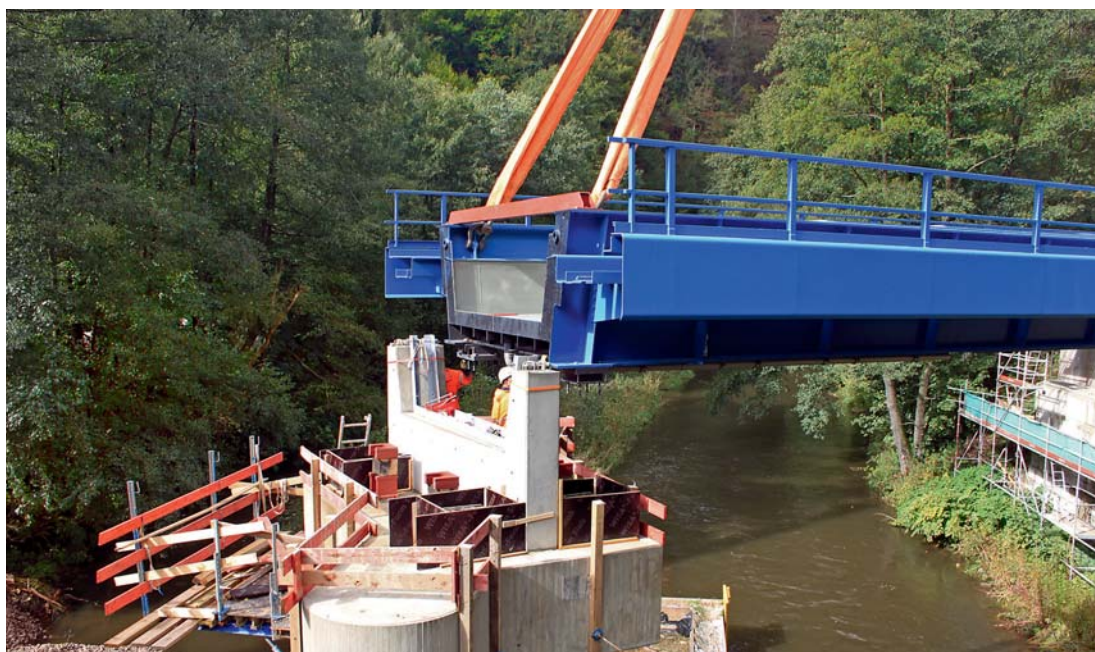
Das Ablegen der beiden Überbauten war Zentimeterarbeit. Anschließend erfolgte gleich die erste Inspektion.
