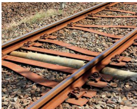
Bei Seilzugdurchführungen werden gerade Stahlschwellen eingebaut.
