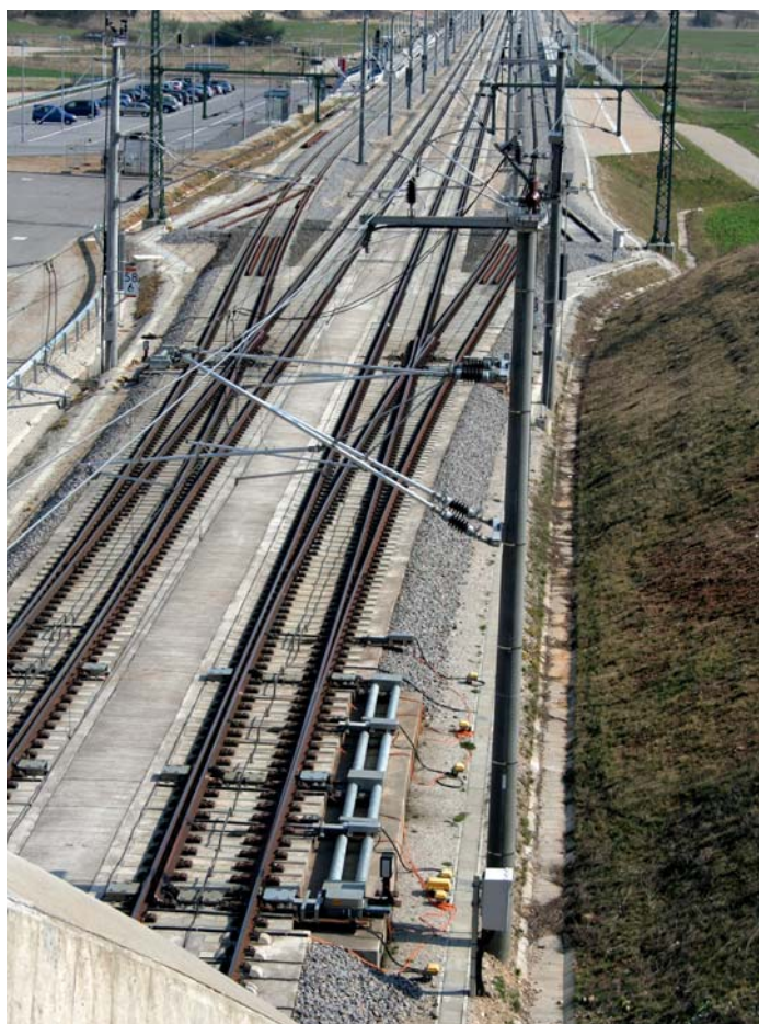
Die durchgehenden Streckengleise im Bahnhof Kinding und auch die anschließenden Tunnelabschnitte sind als Feste Fahrbahn ausgeführt.
