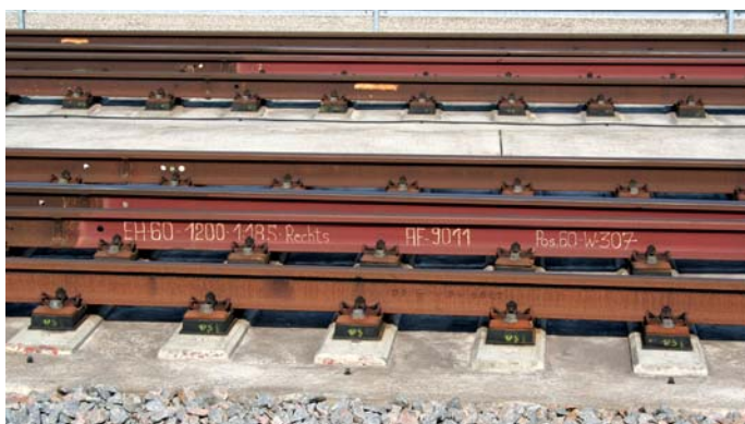
„EH-60-1200-1:18,5“: Die Weichenbezeichnung ist auf dem Schienenprofil vermerkt. Die Weiche ist im Abzweig mit 100 km/h befahrbar.
