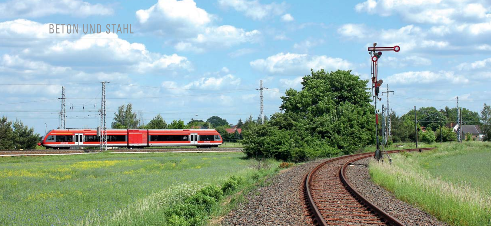
Einfahrt Löwenberg (Mark), 25. Mai 2011: Auf der Hauptstrecke rollt ein 646 (GTW 2/6) aus Richtung Neustrelitz ein. Der Oberbau der von Herzberg (Mark) herführenden Nebenstrecke wurde nach der Wende mit Y-Stahlschwellen saniert.
