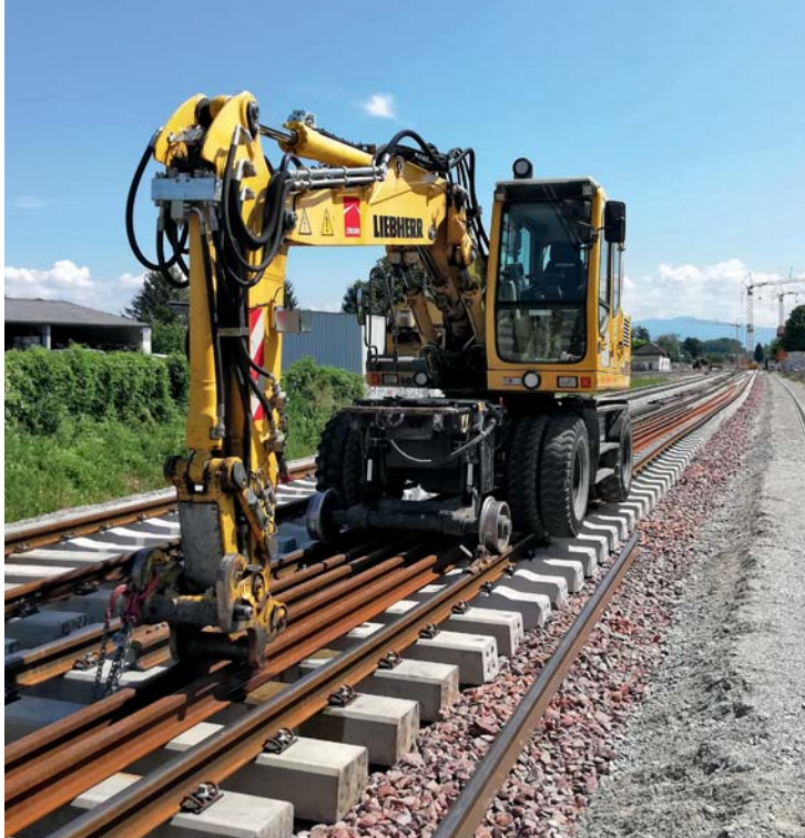
Umbau für die Breisgau-S-Bahn in Gottenheim: Vor dem Bagger erkennt man gut den Übergang von B70- auf Weichenschwellen.
