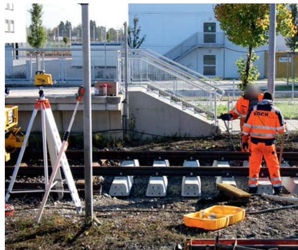
Mächtige Brocken: In manchen Fällen werden die mit dem Bagger verteilten B70-Betonschwellen per Hand ausgerichtet.
