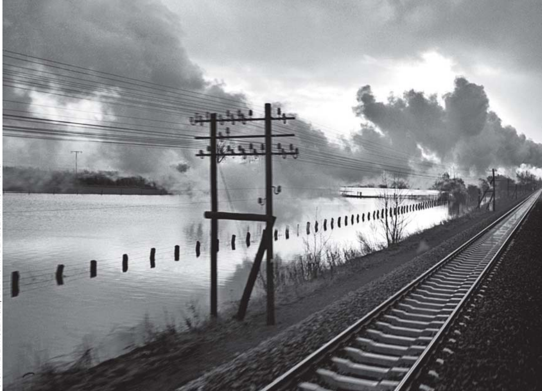
Im Jahr 1958 tatsächlich noch modern: Betonschwellengleis zwischen Nienburg und Uelzen. Der Fotograf war vermutlich eher von der Stimmung mit Dampfzug und Hochwasser angetan.
