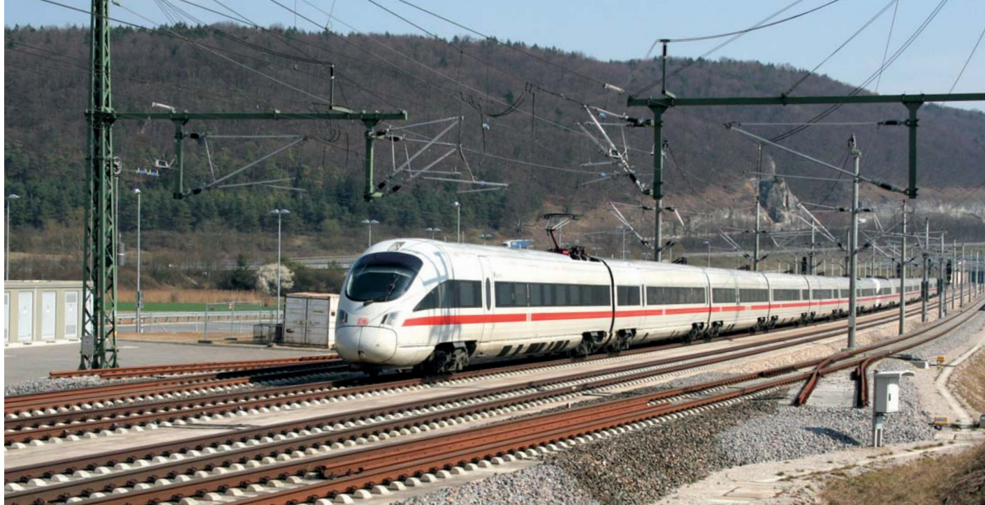
Regionalbahnhof Kinding an der Neubaustrecke Nürnberg – Ingolstadt: Für die beiden Bahnsteiggleise erfolgt der Wechsel von der Festen Fahrbahn zum herkömmlichen Schotter-Oberbau. Der Übergangsbereich wird mit zwei zusätzlichen Schienenprofilen stabilisiert.
