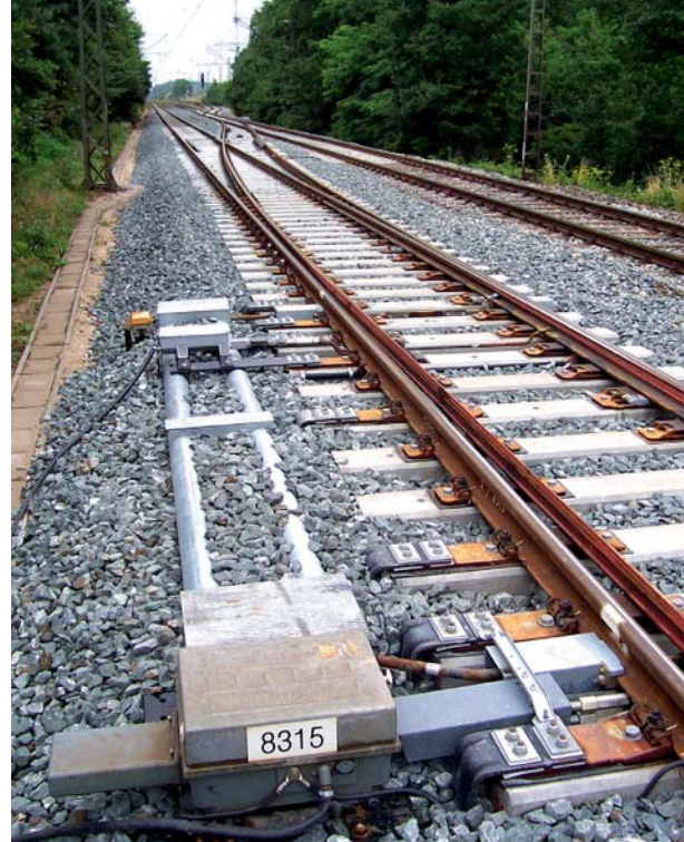
Umbau für die Breisgau-S-Bahn in Gottenheim: Vor dem Bagger erkennt man gut den Übergang von B70- auf Weichenschwellen.
