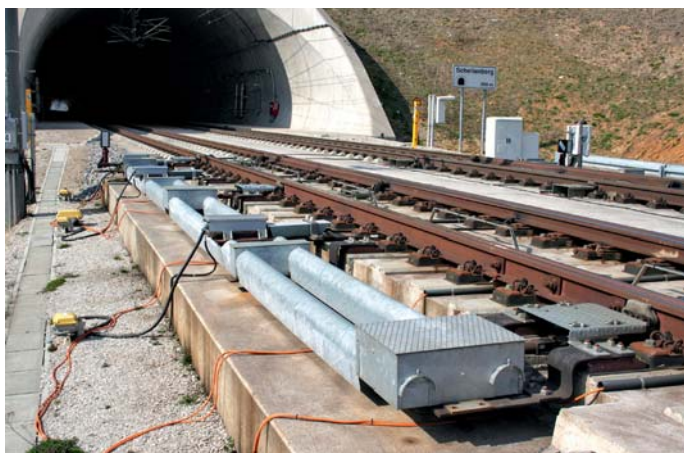
Dazu ist ein dreifacher Antrieb der langen Weichenzungen nötig. Die Weiche mit beweglicher Herzstückspitze ist über 64 Meter lang.
