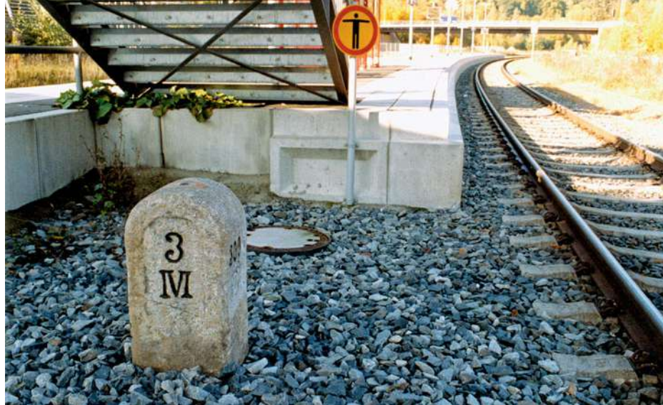
Während der Umbauarbeiten am Haltepunkt Wilkau-Haßlau (KBS 450) im Jahr 2008 wurde ein alter Myriameterstein aus dem Jahr 1858 vom Bau der Obererzgebirgsbahn Zwickau – Schwarzenberg wiederentdeckt und nach einer Restaurierung wieder aufgestellt.
