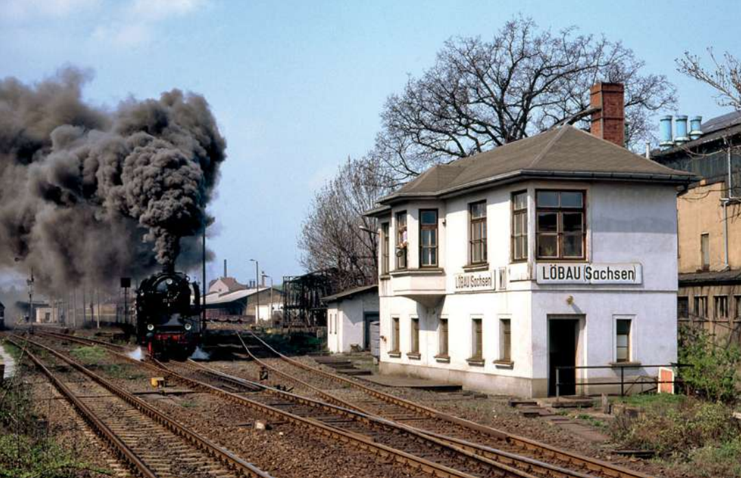
Die gewölbten Blechtafeln aus der Reichsbahnzeit wie in Löbau wurden bei Bedarf, wenn sie etwa durchgerostet waren, durch gefalzte Rechtecktafeln ersetzt.
