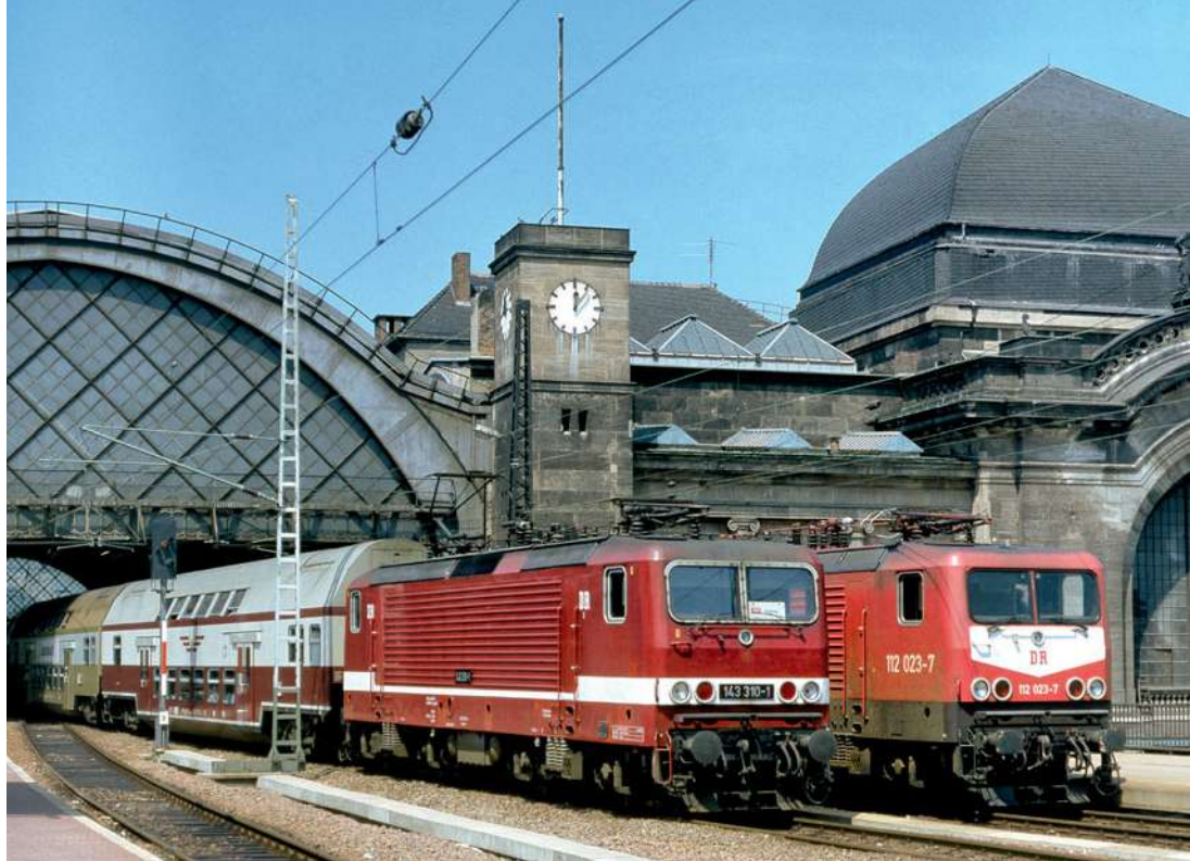
Der am 13. Februar 1945 stark zerstörte Dresdner Hbf wurde bis Anfang der 60er-Jahre wieder aufgebaut. Als eine der letzten Maßnahmen erfolgte die Anpassung der Uhrtürme zu beiden Seiten des Eingangsportals an die entfeinerte Fassade.
