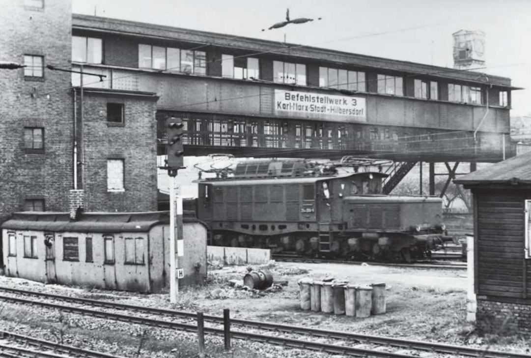
In Karl-Marx-Stadt-Hilbersdorf war der Kasten eines preußischen Oberlichtwagens neben dem Brückenstellwerk der Seilablaufanlage eine Rangiererunterkunft.
