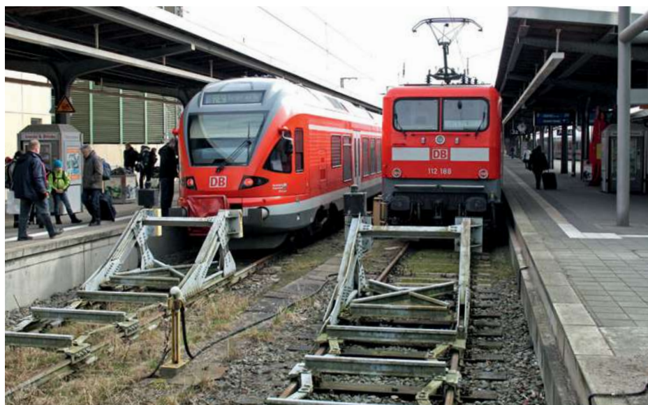
Bremsprellböcke im Bahnhof Stralsund. Sie sind in der Lage Bewegungsenergie zu absorbieren.
