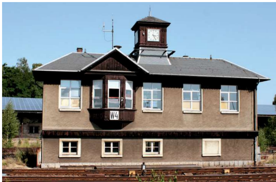
Das Stellwerk W4 in Zittau aus dem Jahr 1910 wird von einer holzverkleideten Turmuhr geprägt. Es liegt an der Westausfahrt zwischen den Gleisen 2 und 6.
