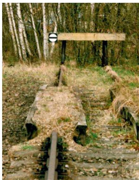
Die Sandaufschüttung vor dem Prellbock dient der Geschwindigkeitsreduzierung.
