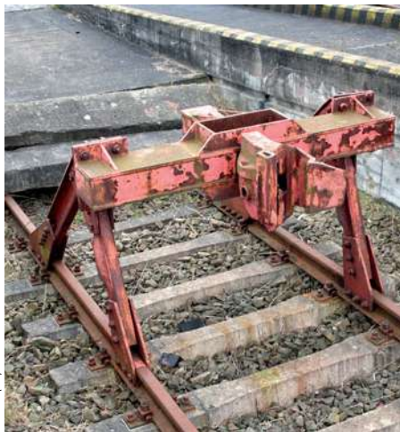
Spezielle Prellböcke für Breitspurfahrzeuge mit Mittelpufferkupplung gibt es nur am Bahnhof Mukran.
