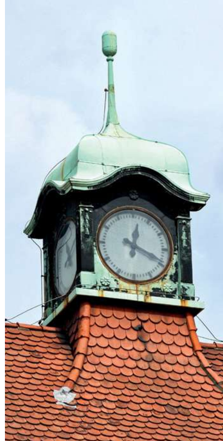
Die Meiningener Turmkrönung mit patiniertem Kupferblech bietet heute einen sichtbar guten Kontrast zum roten Tondachziegeldach.
