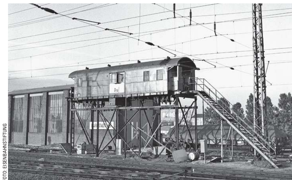
Vor der Inbetriebnahme des Dr-Stellwerks „Df“ (1972) am Darmstädter Hbf stand am nördlichen Gleisvorfeld dieser aufgebockte Wagenkasten als Behelfsstellwerk „Du“ (27. Mai 1969).
