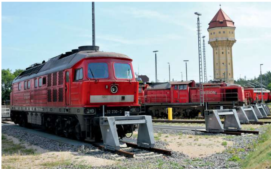
Mit dem modernen Klose-Bremsprellbock des Typs BP 106B sind seit 2012 die Strahlengleise im Werk Nürnberg Rangierbahnhof ausgestattet.
