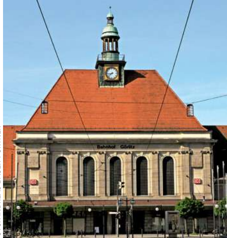
Eine beeindruckende Turmuhr besitzt das Görlitzer Empfangsgebäude.
