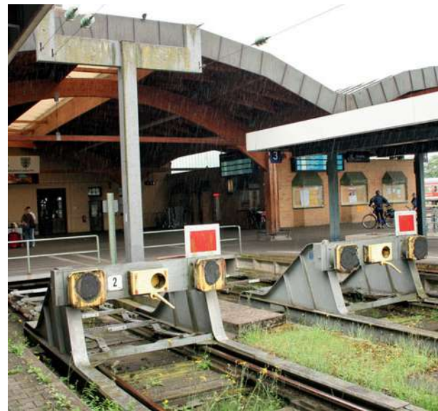
Ein Bremsprellbock mit Aufnahme für eine Mittelpufferkupplung in Lindau.
