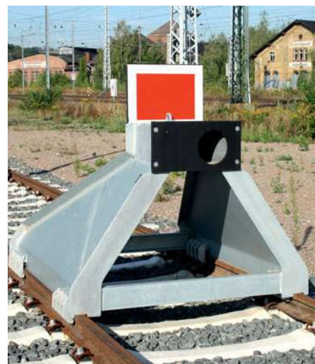
In Sangerhausen steht der Rawie FP8899 für Triebzüge mit Scharfenberg-Kupplung.
