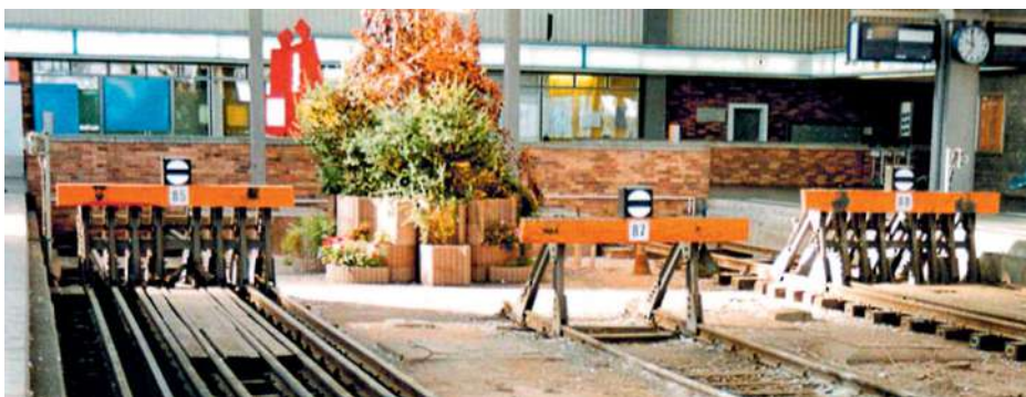
In der Chemnitzer Bahnsteighalle kann der Eisenbahnfreund Bremsprellböcke mit mehreren Bremsschienen vereint mit einem Festprellbock beobachten.
