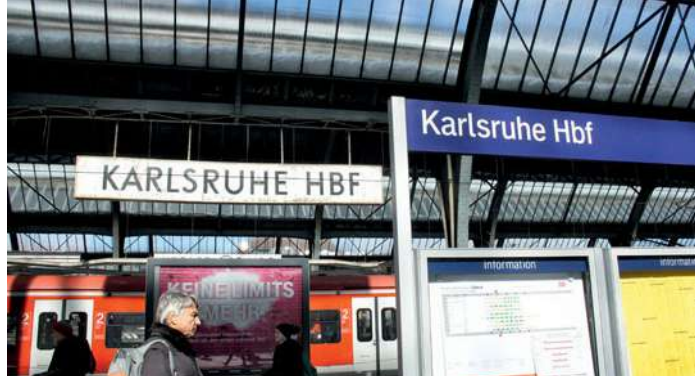
Die zirka fünf Meter langen und einen Meter hohen, überdimensionalen alten Karlsruher Emailleschilder sind mit jeweils vier Profilstahlträgern an der Stahlkonstruktion des Hallendaches befestigt.
