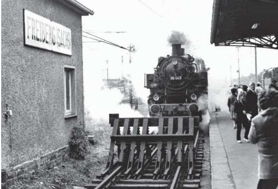
In Freiberg/Sachsen kommt 86 049 am 12. Juli 1986 rechtzeitig vor einem Bremsprellbock mit zahlreichen Bremsschienen zum Stehen.
