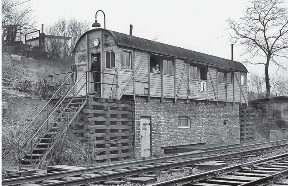
Ein alter Wagenkasten diente als Behelfsstellwerk „P“ in Essen Rangierbahnhof. Bei dem verwendeten Wagen handelt es sich um einen GI Dresden polnischer Bauart (GI 90).
