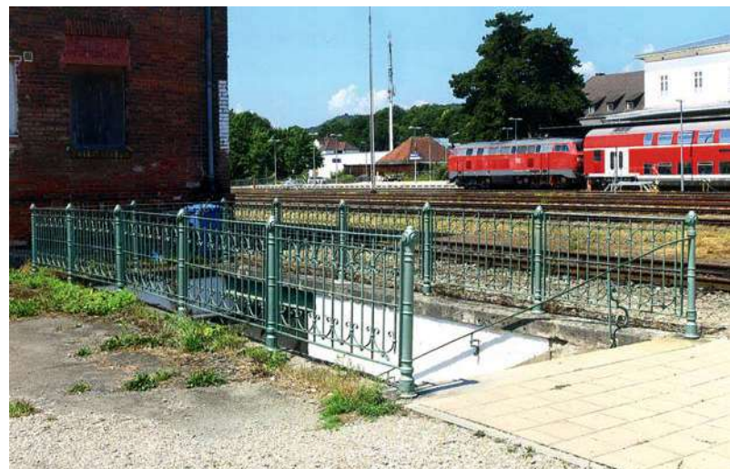
Auf dem Bahnhof Simbach am Inn blieben trotz Modernisierungsmaßnahmen diese alten Bahnsteiggeländer auch an der Fußgängerunterführung erhalten.
