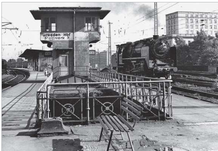
Auf der Südseite des Dresdener Hbf führen Gleise und Bahnsteig über die B170. Im Bereich des ehemaligen Stellwerks 2 sicherte ein altes Bahnsteiggeländer, das dem ICE-tauglichen Umbau zum Opfer fiel, Reisende.
