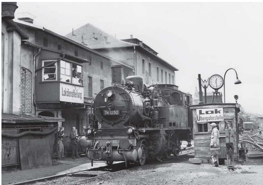
Diese aufgeständerte „Dienstuhr“ befindet sich auf dem Dach des Weichenpostens im ehemaligen Bahnbetriebswerk Zittau.
