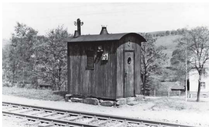
Diese erweiterte Bauform der standardisierten Wellblechbude auf dem Bahnhof Schlettau diente als Aufenthaltsraum für den Weichenwärter und war mit einem Ofen beheizbar.
