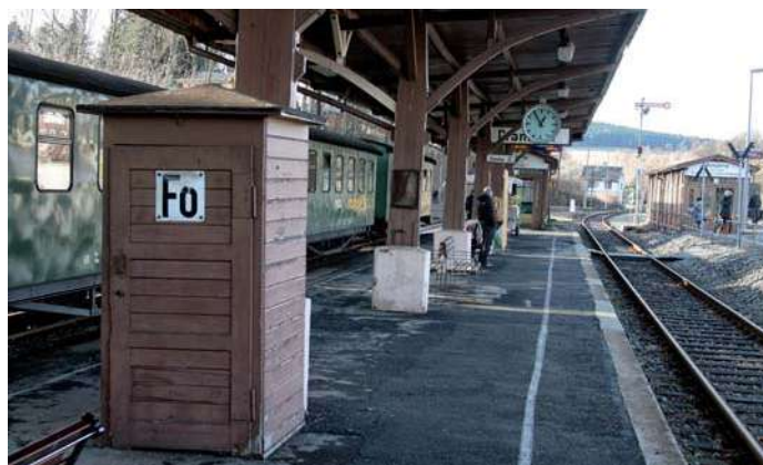
Das Diensttelefon für die Bahnhofsringleitung (Fo) war in unterschiedlichen Fernsprekbuden untergebracht. Eine häufige Bauform waren Holzbuden, zum Beispiel auf dem Bahnhof Cranzahl.
