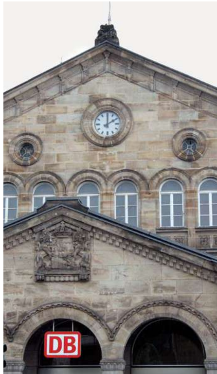
In die Giebelwand des Hbf Fürth ist diese mit Sandstein umrandete Bahnhofsuhr eingelassen, die gut ins historische Ensemble passt.
