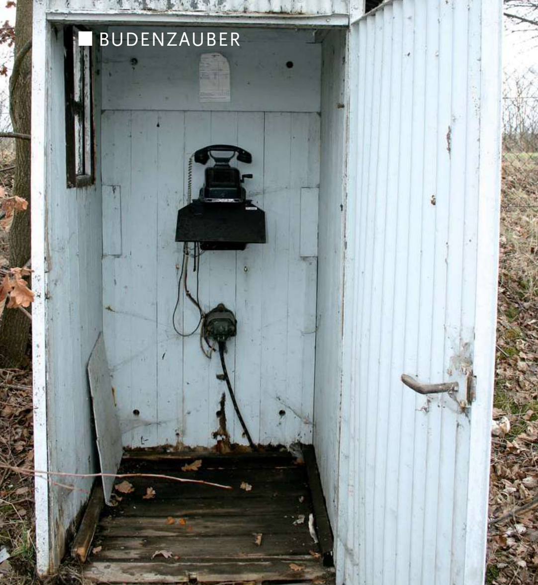
Die Fernsprechbude an einer Einfahrt in den ehemaligen Bahnhof Crossen der Industriebahn Zwickau – Crossen – Mosel ist noch in Betrieb. Das Foto zeigt die Innenausstattung mit Holzauskleidung, dem alten OB-Fernsprecher und der Rufzeichentafel.
