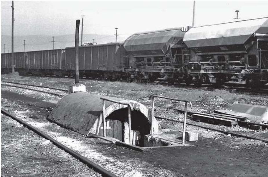
Den wohl abenteuerlichsten Erdkeller gab es zu DR-Zeiten auf dem Güterbahnhof Saalfeld und er diente als Rangierunterkunft. Das Dachgewölbe ist mit Bitumenpappe abgedichtet.
