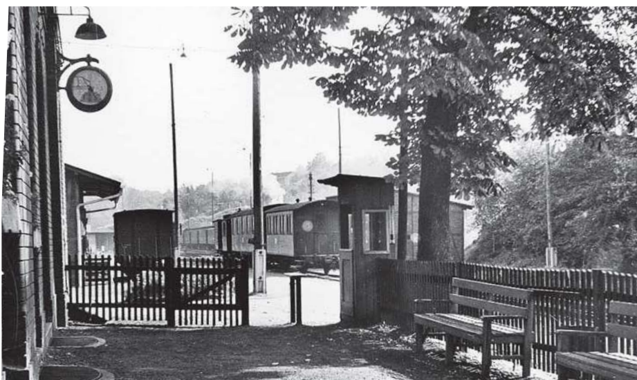
Holzbänke aus Brettern konnte man bei der DR häufig auf Nebenbahnen antreffen. Am Schmalspurbahnhof Gera-Pforten standen diese Bänke vor der Bahnsteigsperr.
