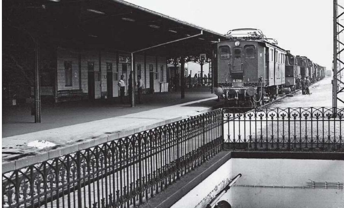
Dieses aufwendig verzierte Geländer blieb auf dem Bahnhof Freiberg/Sachs erhalten. 1986 diente es als Kulisse für eine Fahrzeugausstellung am benachbarten Bahnsteig 5.
