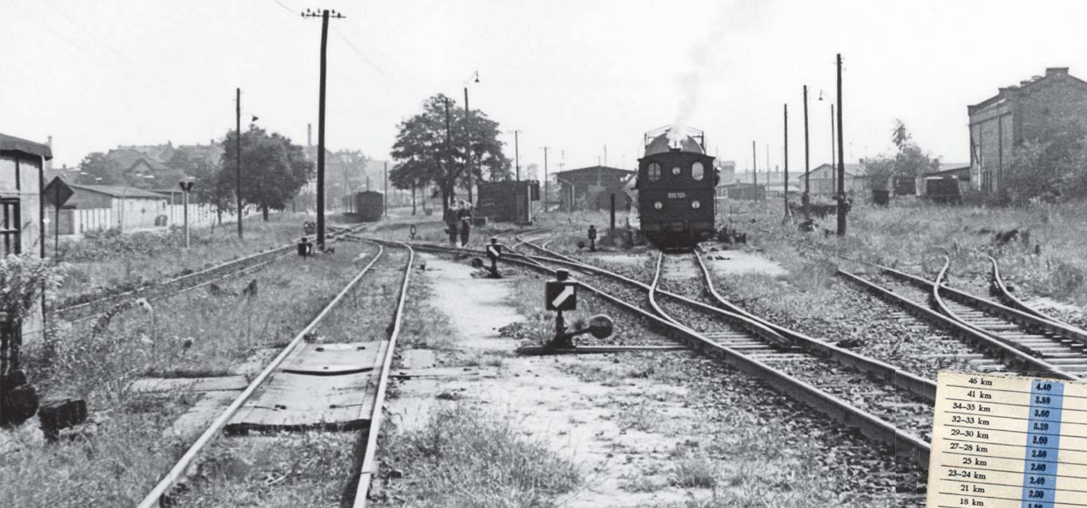
Der Güterbahnhof der Spreewaldbahn in Cottbus: Von einst drei Rollbock-/Rollwagengruben ist 1968 noch eine in Nutzung. An ihr rangiert 99 5706 gerade einen Zug. Das Gleis links hinten führt zum Personenbahnhof.
