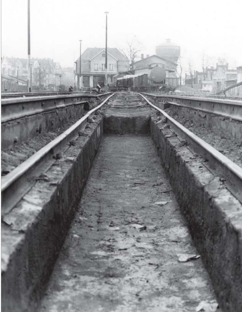
An der Rollbockgrube in Nordhausen – hier am 31. März 1979 – wird das Schmalspurgleis allmählich in die Grube abgesenkt, so dass beim Herausziehen (Beladevorgang) die Normalspurwagen mit ihrem Radsatz erst nach und nach auf den Rollbock aufsetzen.
