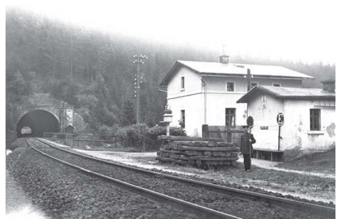
Die historische Aufnahme des Postens CA 23, wie am Giebel des Nebengebäudes zu sehen ist, zeigt hinter der Muldenbrücke das Südportal des Bockauer Tunnels und gleichzeitig die für einen zweigleisigen Ausbau vorgesehene Trasse und das weite Tunnelprofil.
