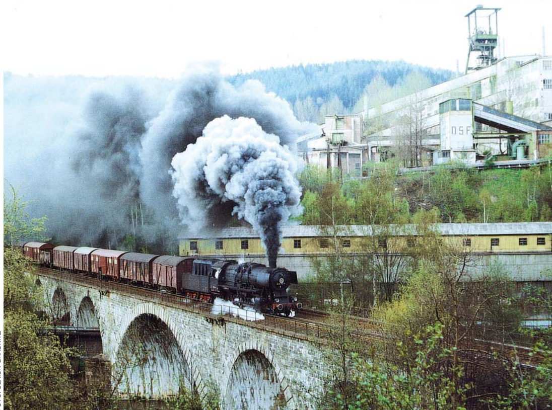
50 2146-4 donnert am 8. Mai 1984 mit beeindruckender Rauchentwicklung über die Muldenbrücke vor der Kulisse des Hartensteiner Schachtes 371 in Richtung Aue.
