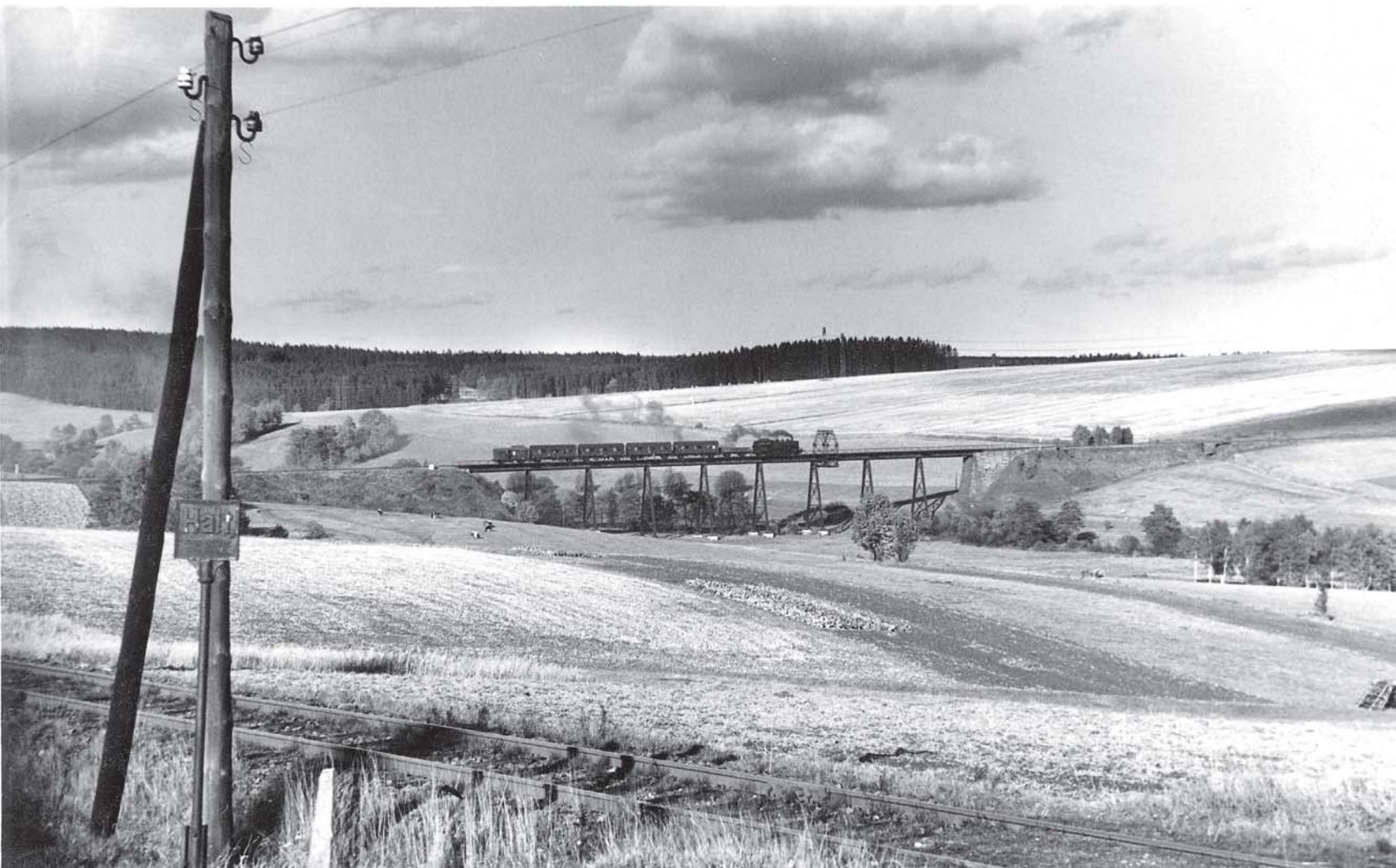
P 1996 befährt, von Elterlein geblickt, den Schlangenbachtalviadukt. Markant war die verschiebbare Plattform für Wartungs- und Messarbeiten.
