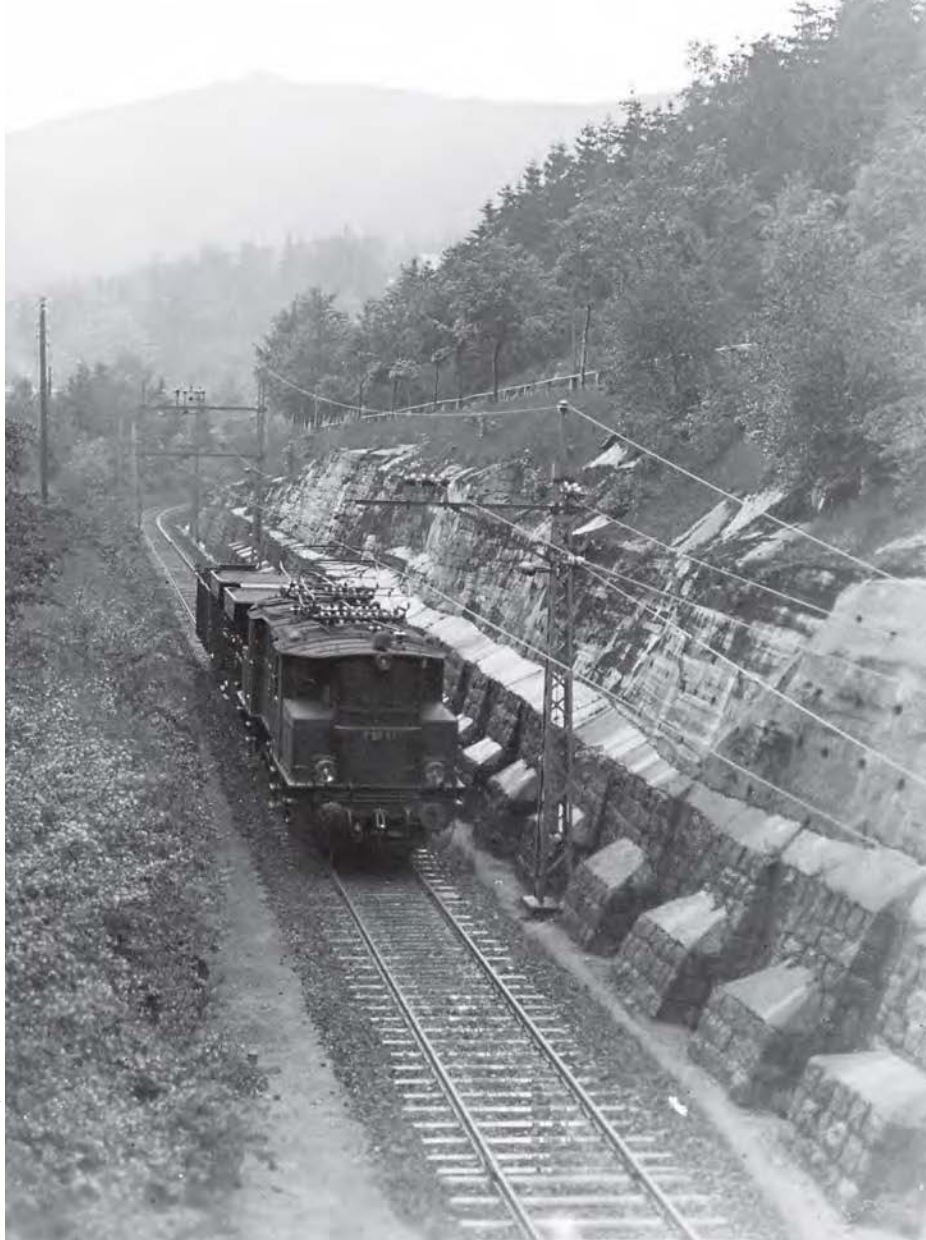
E 90 57 rollt an einer Stützmauer in den Bahnhof Oberschreiberhau ein. Der Gebirgscharakter der Strecke wird auch durch solche Kunstbauten, um Hänge abzufangen, deutlich.
