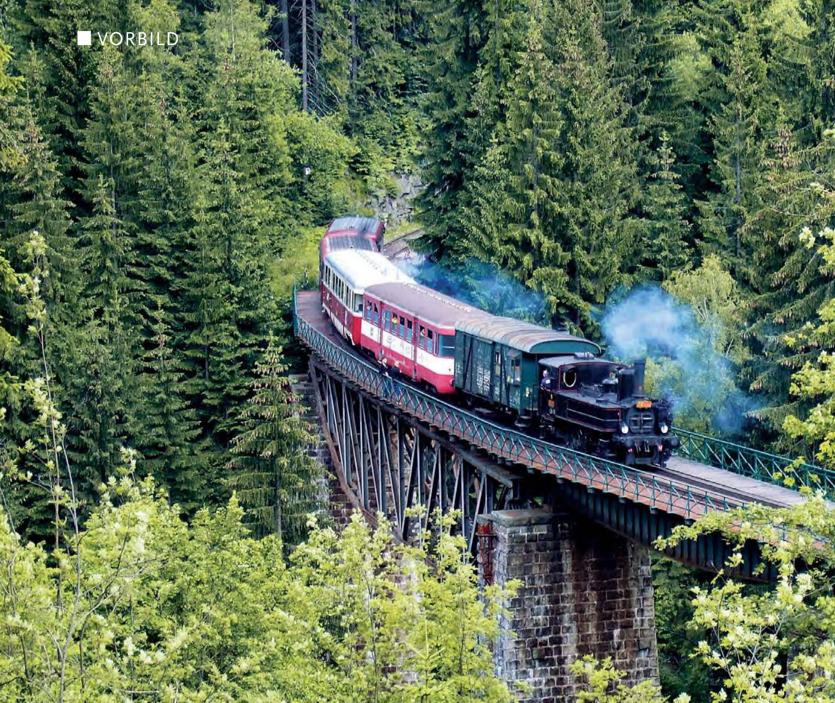
310.0134 schiebt einen Sonderzug auf dem Iserviadukt nach Harrachov nach. Es führt ein 810 den Zug. Die Natur nimmt das 1902 errichtete Brückenbauwerk mehr und mehr ein. Unter dem Gitter-Fischbauchträger fließt die Iser. Der hinten sichtbare Felseinschnitt führt zum Isertunnel.
