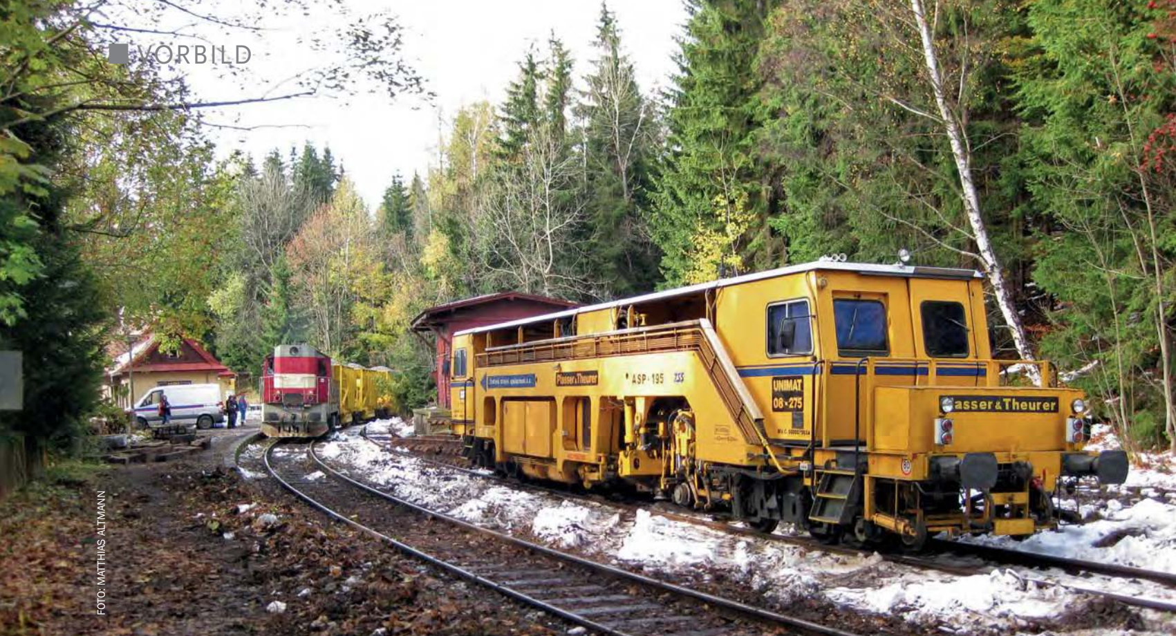
Die Bauarbeiten laufen. Am 25. Oktober 2009 liegt Schnee in Harrachov. Den Standort der Gleisbaumaschine nahmen einst die E 90 ein.
