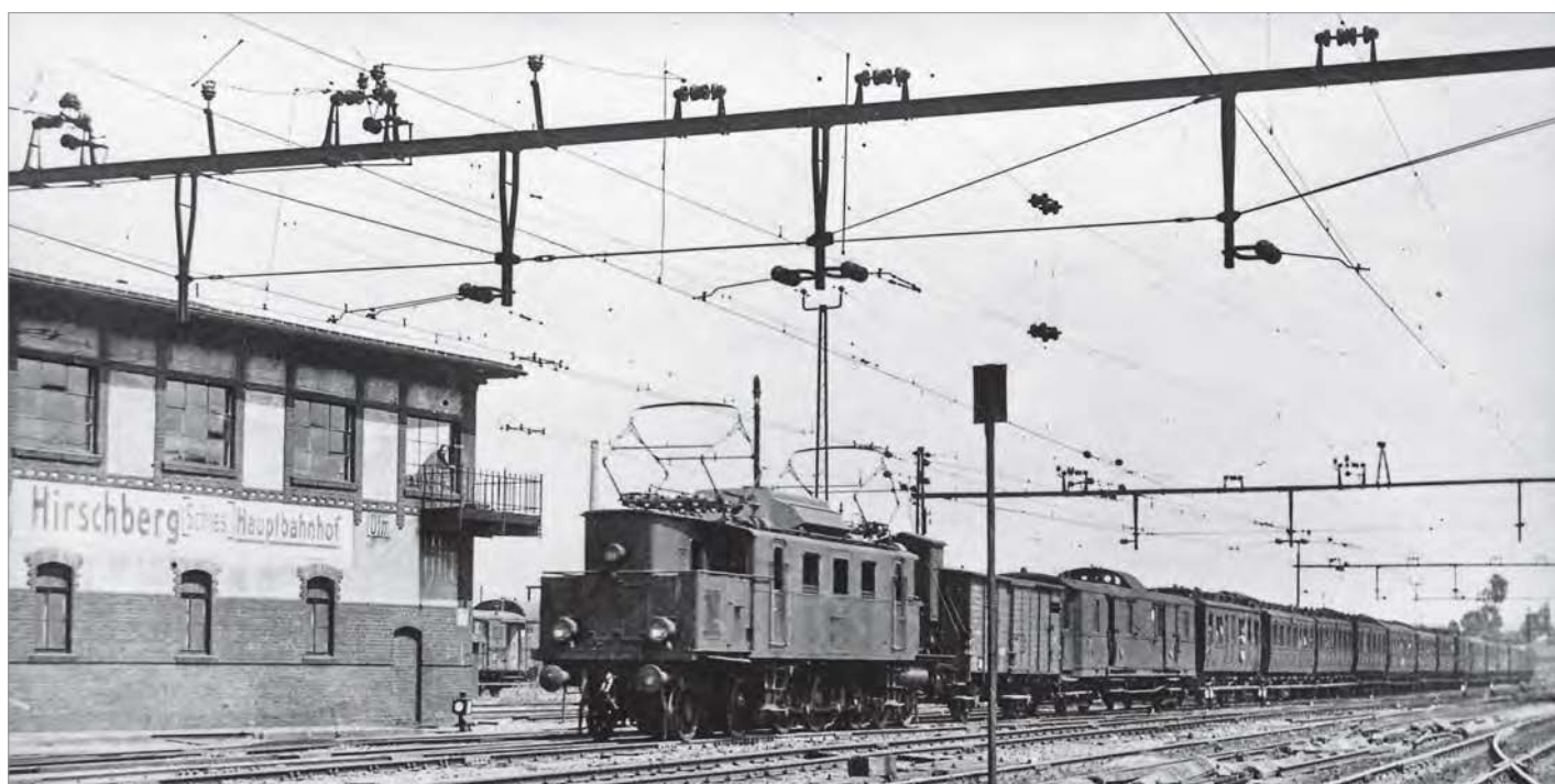
Unter der Oberleitungsanlage Bauart Bergmann-Elektricitäts-Werke AG (BEW) rollt eine E 50.4 durch Hirschberg, noch mit dem Zusatz „Schles“.
