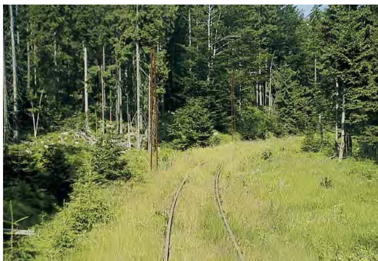
Auf dem polnischen Streckenbereich stehen die alten Fahrleitungsmasten und Tragwerke ein halbes Menschenleben verrostet neben dem überwachsenen Gleis, was zur ersten offiziellen Befahrung 2002 ertüchtigt wurde.
