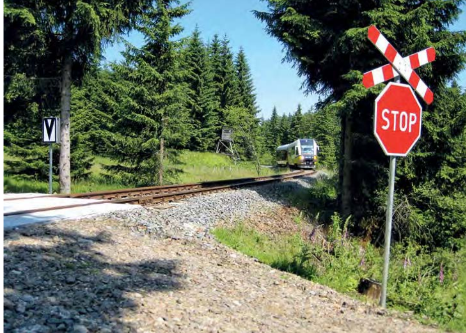
SA 134-006 ist am 10. Juli 2010 in Höhe Gebertbaude auf dem grundhaft modernisierten Streckenabschnitt unterwegs.
