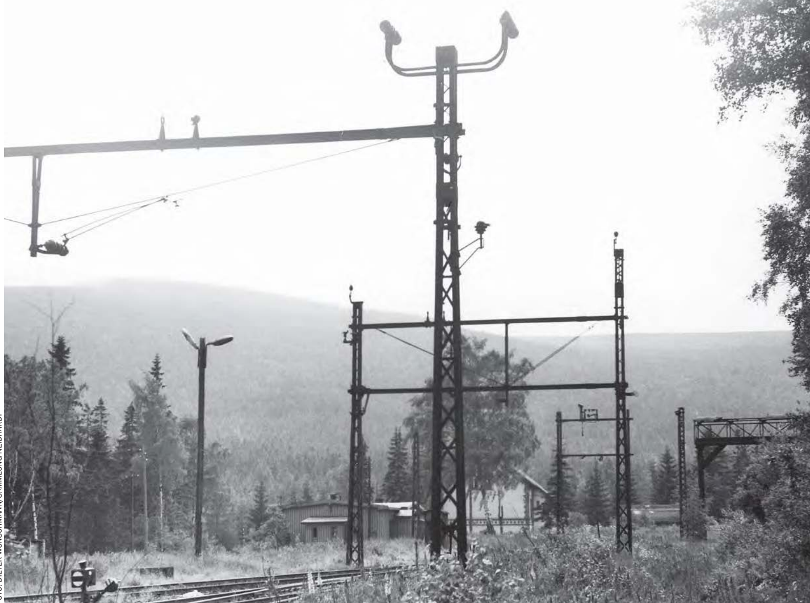
26 Jahre nach dem Abhängen der Fahrleitung konnten 1971 (Blick nach Jakobsthal) noch die Masten und Tragwerke bewundert werden – bis hin zu den Isolatoren und Fahrdrahtaltern!
