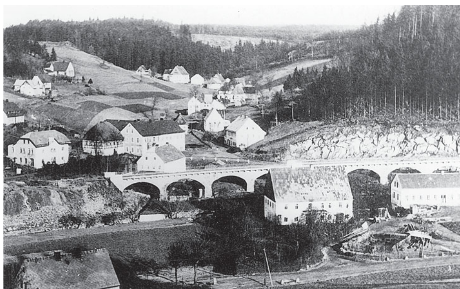
Seitenansicht der Baustelle der Oberlochmühler Viaduktstrecke.
