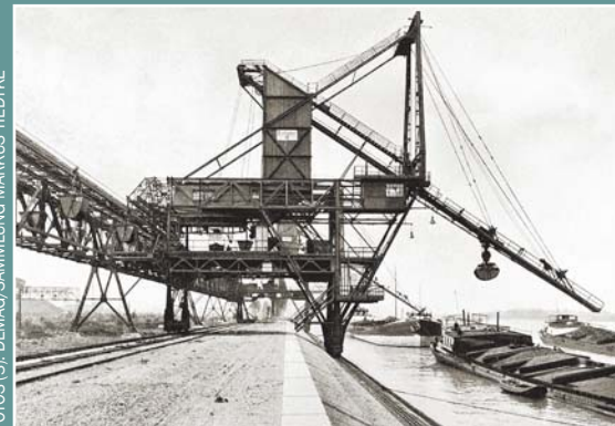
Gleich drei Schrägbahmentlader hoben Schüttgüter aus Schiffen und versorgten die BASF in Ludwigshafen per Seilbahn.
