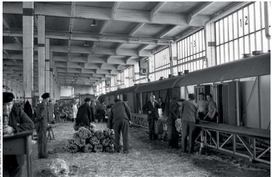
Frisch eingetroffene Bananen werden im Schuppen 35 des Segelschiffhafens 1934 auf mobilen Förderbändern transportiert sowie kontrolliert und gelangen schließlich in Kühlwagen.
