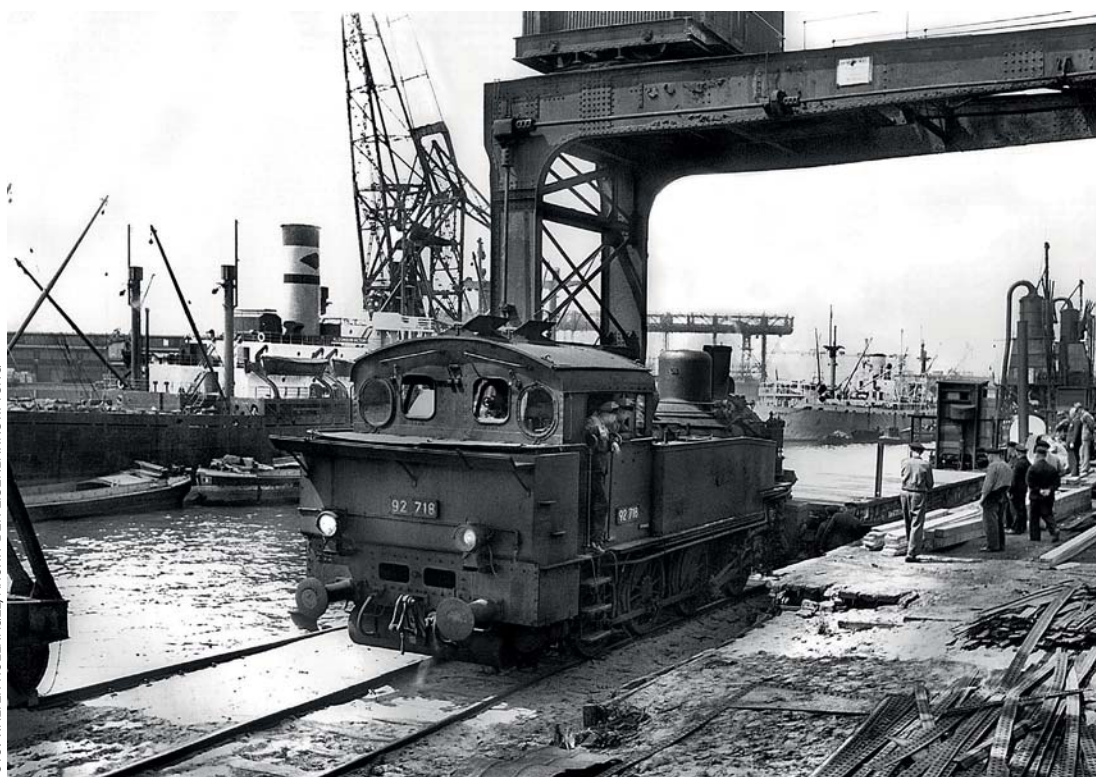
92 718 vom Bw Wilhelmsburg hilft beim Wiederaufbau der zerstörten Kaianlagen im Hafen. Hinter der Lok ist ein Schwimmkran beim Be- und Entladen eines Schiffes zu sehen.
