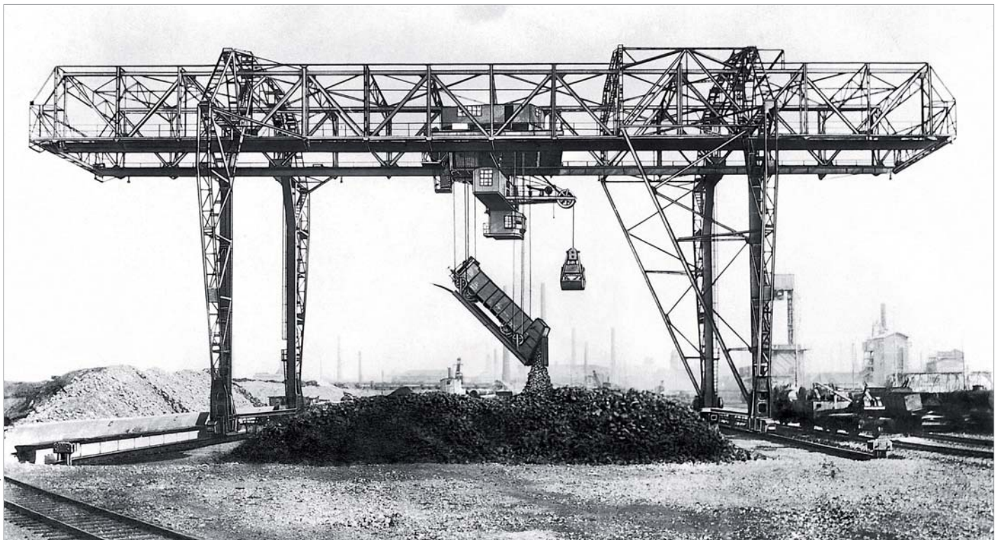
DEMAG baute mehrere Kipperkatzenverladebrücken für einige Häfen. Der Kran hob den Wagen und leerte ihn. Der Greifer schlug die Kohle um.
