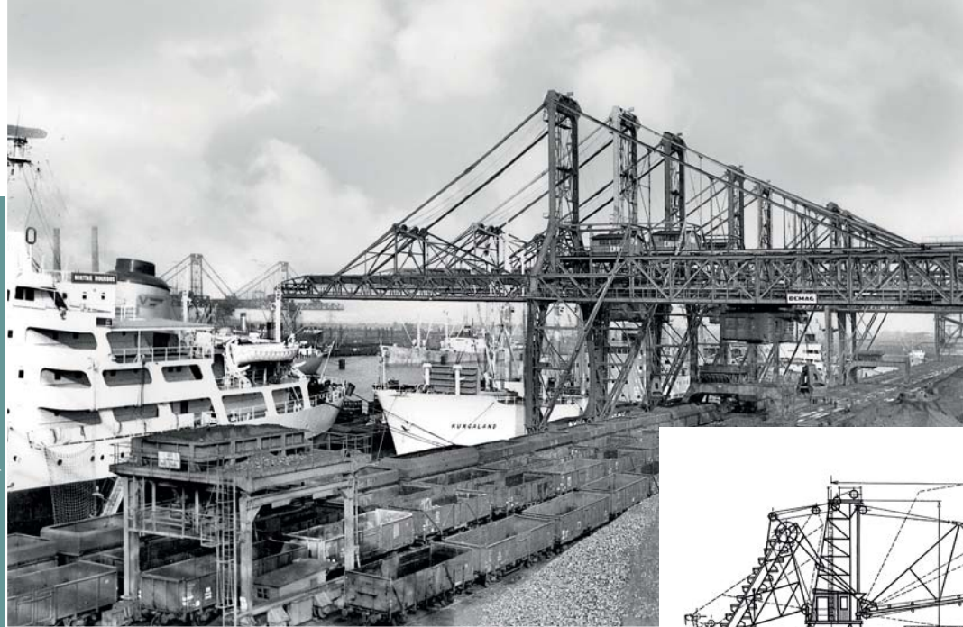
Den Erzumschlag vom Schiff an Land erledigen um 1956 in Emden gewaltige Verladebrücken mit Greiferlaufkatze. Die weit über das Wasser ragenden Arme sind für Schiffsbewegungen hochklappbar.
