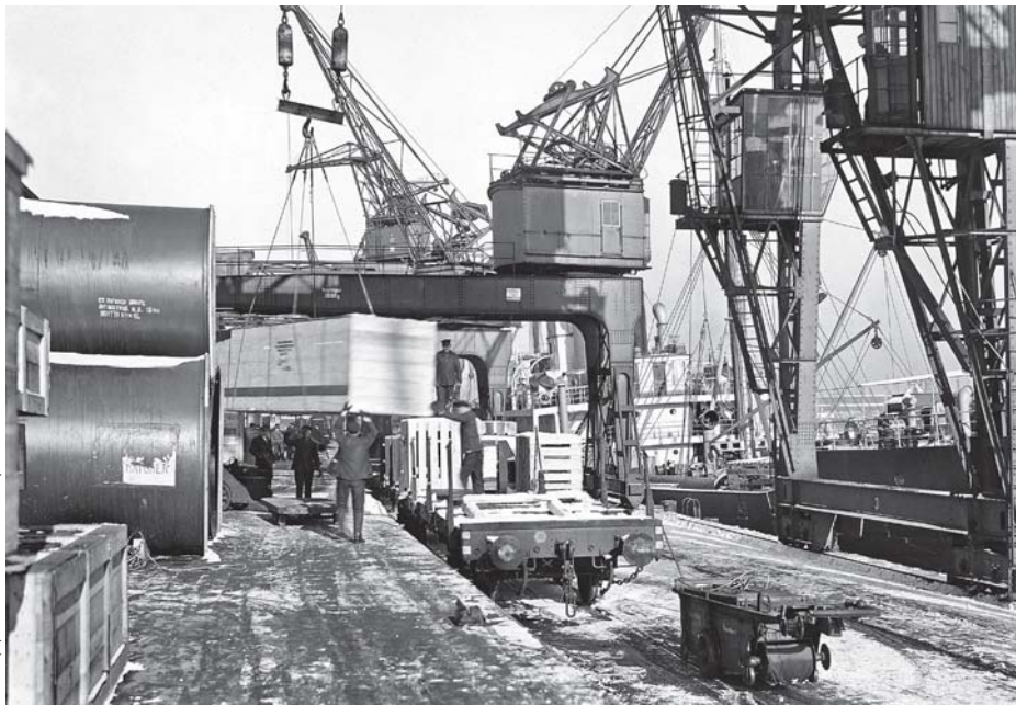
Mit einer mobilen Rangierwinde hat man 1956 Wagen zur Beladung zum Kran vor der Schuppenrampe gezogen.
