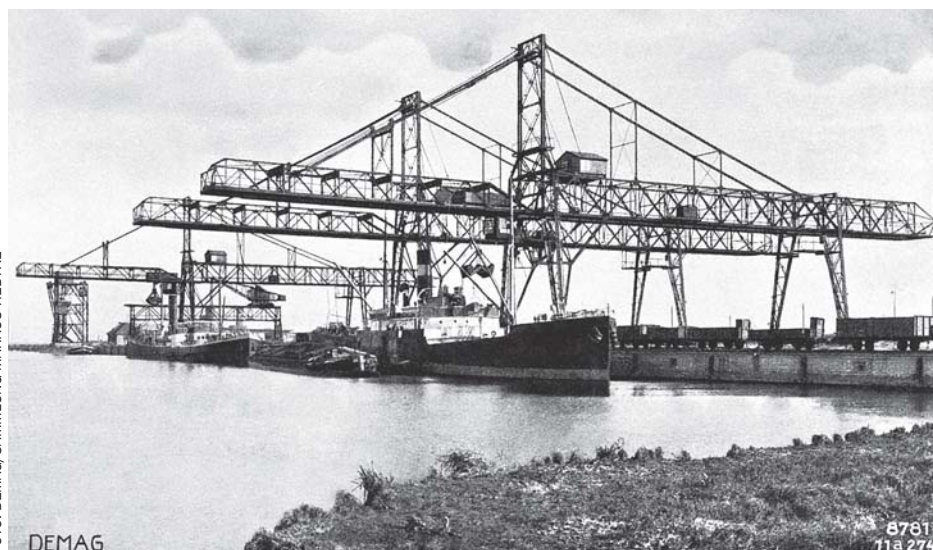
Im Erz- und Kohlehafen von Stettin errichtete DEMAG um 1910 drei fahrbare Verladebrücken, deren weit über das Wasser reichende Ausleger für Schiffsbewegungen hochklappbar waren.
