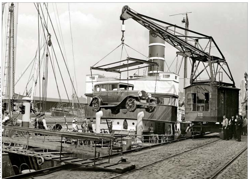
1934 verlud man im Grasbrookhafen am Schuppen 18 mit speziellem Krangeschirr ein Auto auf ein Schiff nach Norwegen. Limousinen waren als Ladung im Hafen etwas Besonderes.
