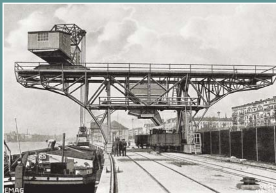
Im Berliner Osthafen verlud ein Greiferdrehkran die per Schiff ankommende Kohle ins Lager oder direkt auf Güterwagen. Im Sammelbehälter wurde gewogen.
