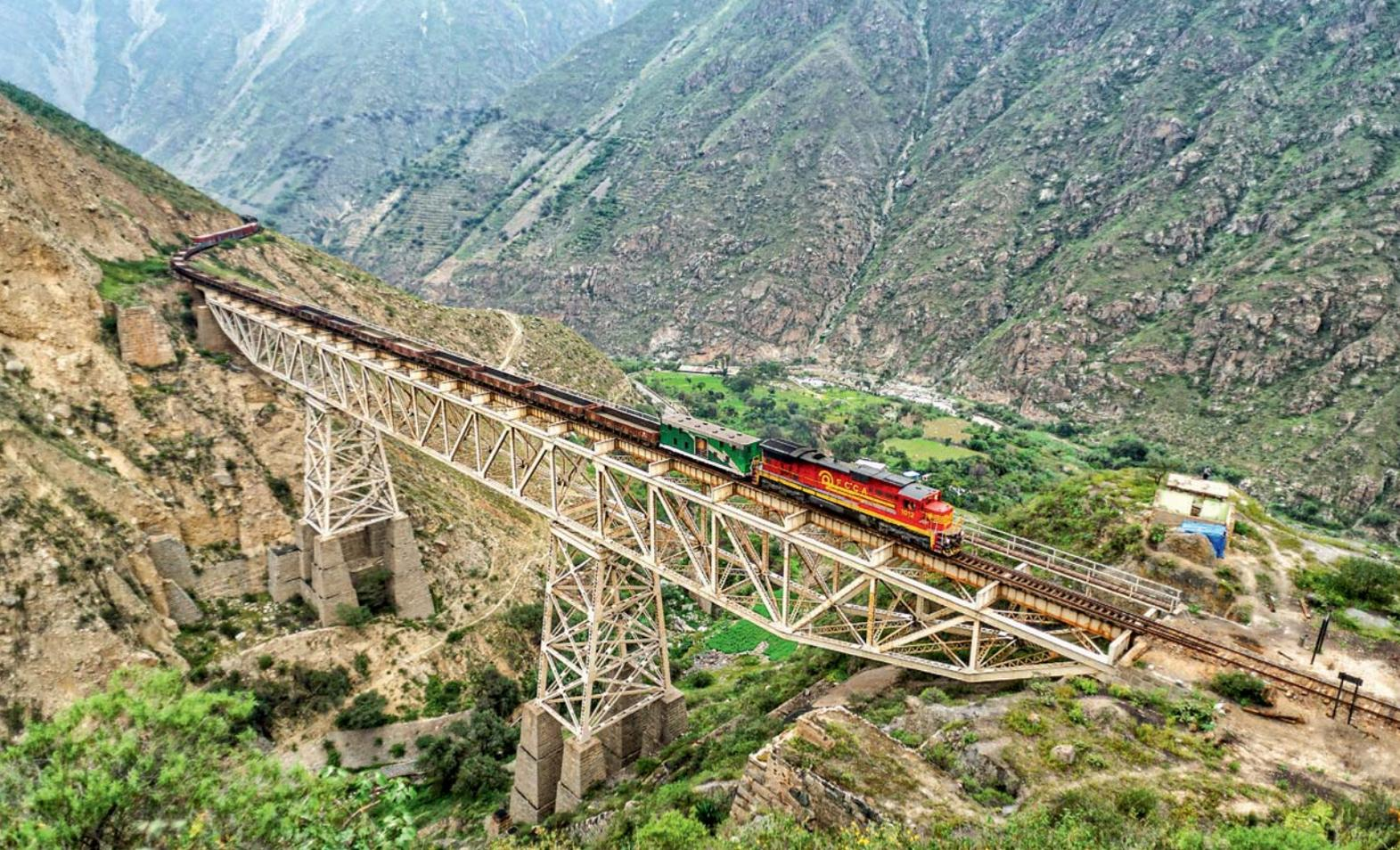
Auf einer Höhe von 1775 Metern ist die gewaltige Carrión-Brücke der erste herausragende Kunstbau für Züge aus Lima. Nachdem sie zweimal wiederaufgebaut werden musste, wählte man eine besonders massive Konstruktion. Reste der alten Brücken sind links zu erkennen.
