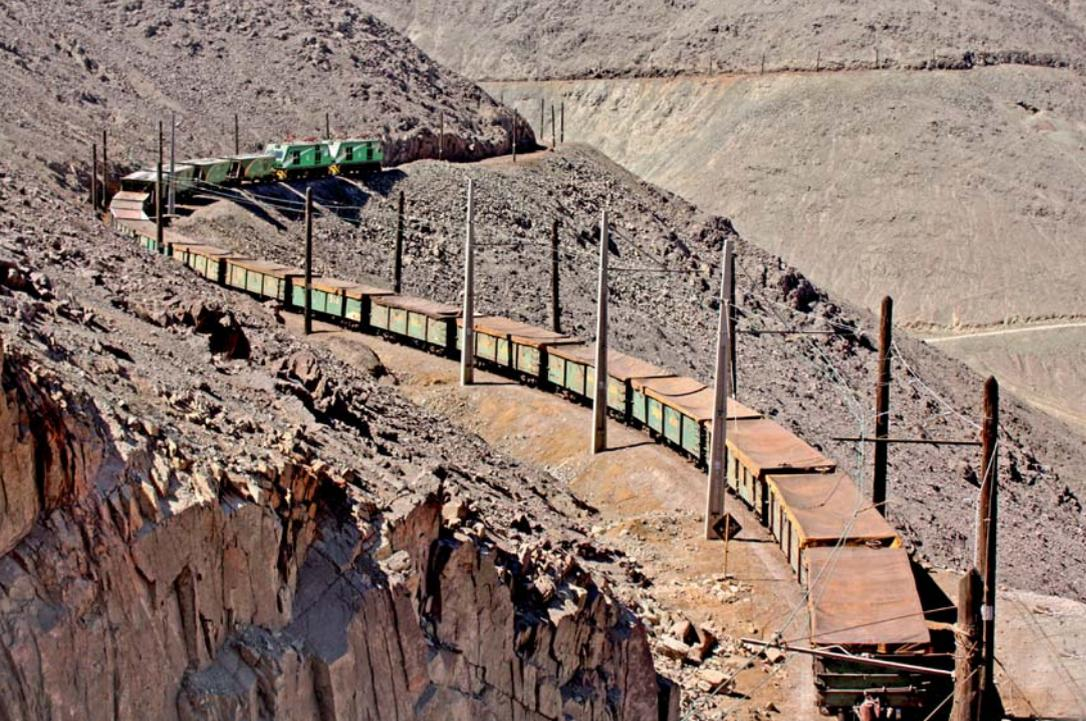
Ohne Kunstbauten schraubt sich die Bahn mit ausgreifenden Schleifenentwicklungen bei 40 Promille und mit 55-Meter-Radien über 1000 Meter bergwärts.
