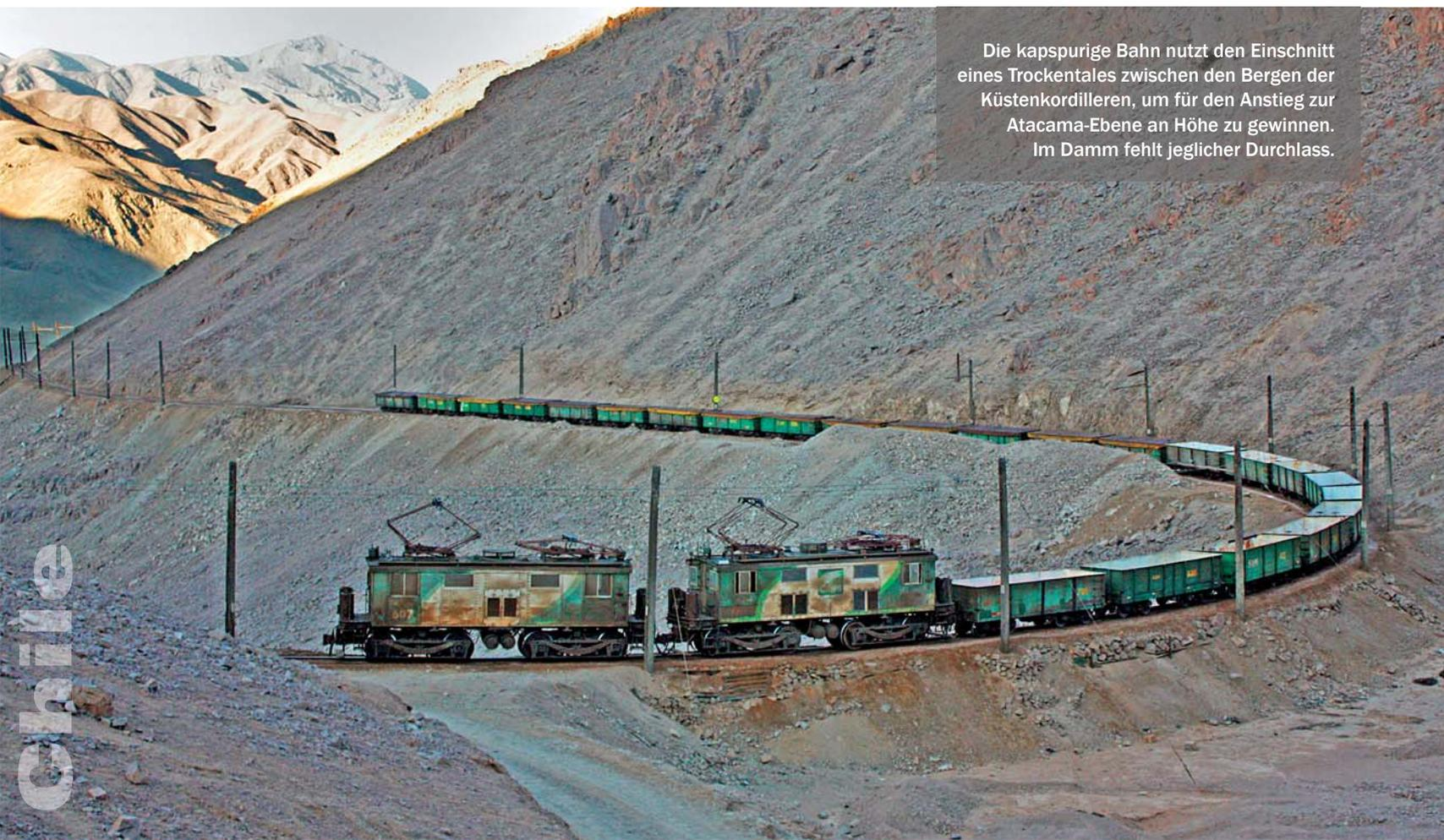
Die kapspurige Bahn nutzt den Einschnitt eines Trockentales zwischen den Bergen der Küstenkordilleren, um für den Anstieg zur Atacama-Ebene an Höhe zu gewinnen. Im Damm fehlt jeglicher Durchlass.
