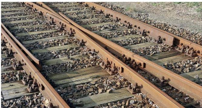
Weichen in der klassischen Bauform liegen an den Stößen der Hauptbaugruppen auf Doppelschwellen. Dort wurden die Schienenprofile bis zur Einführung des Schienenschweißens mit Laschen verschraubt. Im Bild oben ist der Herzstückbereich einer EW 49-190-1:9 mit den Radlenkern an den Backenschienen zu erkennen. Man sieht die Doppelschwellen und die Verschraubung vor dem Herzstückbereich. Rechts sind die Zungenspitzen und der Verschluss mit dem Handstellhebel derselben Weiche abgebildet.
