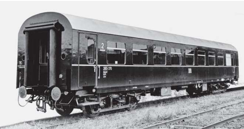
Seitenansicht eines frühen Rekowagens aus dem Jahr 1966, der zu den letzten Waggonen auf preußischen Regeldrehgestellen gehörte.
