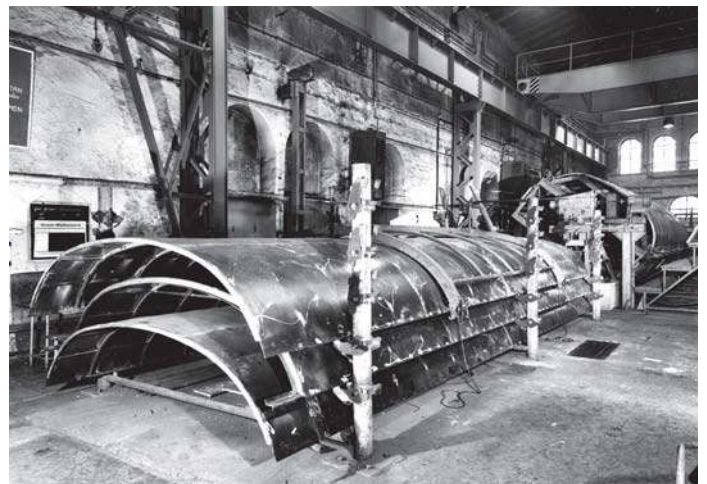
Dachrohteile - vorn abgelegte fertige Dachsegmente, hinten Dachschlussvorrichtung.
