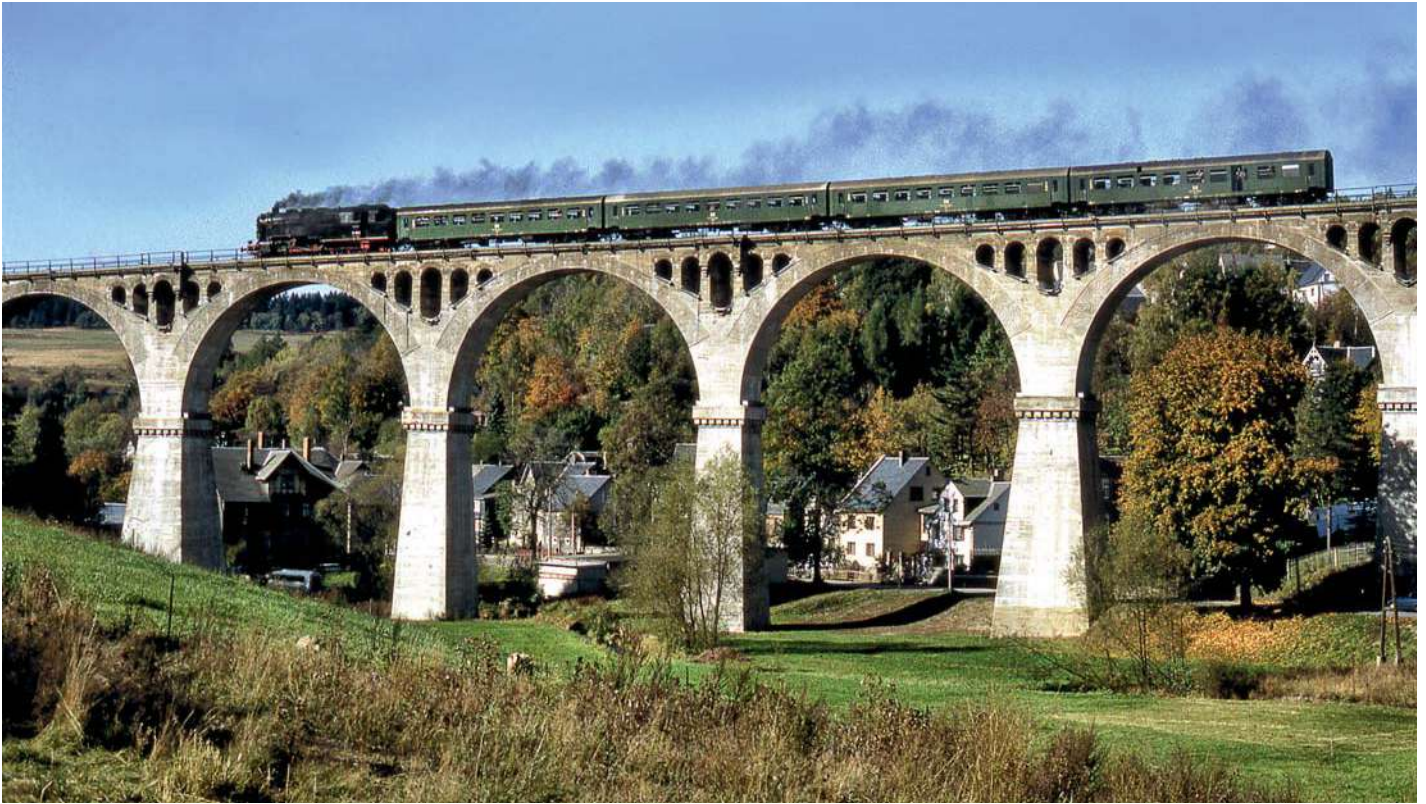
95 1027 mit Rekos am 11. Oktober 1992 auf dem Piesau-Viadukt, das eine Länge von 258 Metern und 34 Meter Höhe aufweist.
