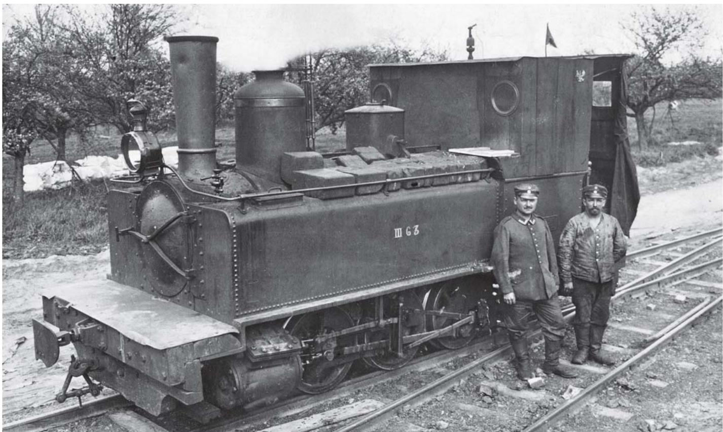
Heeresfeldbahn einverlebte III G 3: Nordfrankreich und Belgien durchzog ein dichtes Kleinbahnnetz auf 600- bis 1000-Millimeter-Spur.
