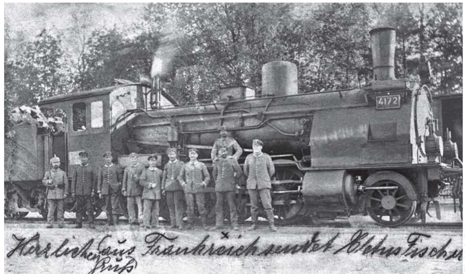
**1915 schickte Militäreisenbahner Cletus Fischer, selbst vor der Lok posierend, diese Aufnahme der G 5.2 4172 nach Hause. Die K.P.E.V.-Maschine kam 1918 als 1981 zur PO.**
