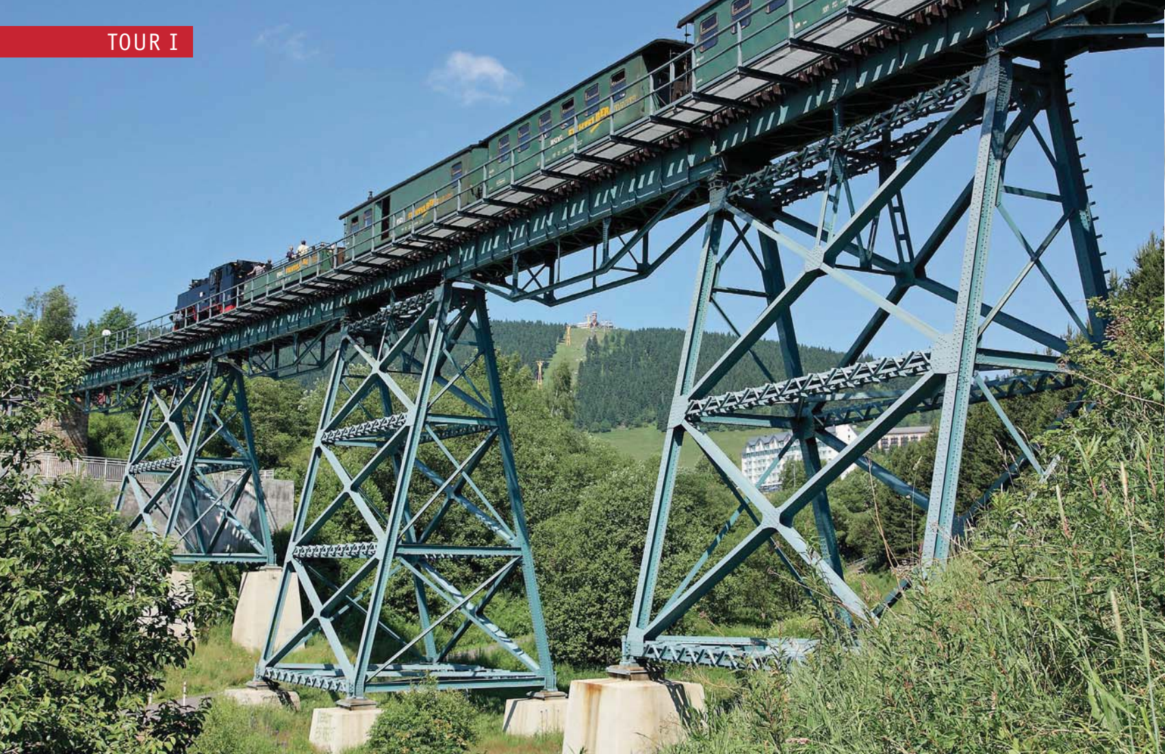
Ankunft im Kurort Oberwiesenthal: Durch den Hüttenbachthalviadukt an der Einfahrt in den Endbahnhof fällt der Blick zum Fichtelberg.
