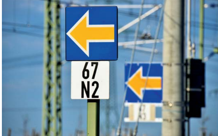
ETCS-Halt-Tafeln (Signal Ne 14, Halt für Züge mit ETCS-Betriebsart SR) stehen anstelle von Licht-Hauptsignalen an der VDE8.2.
