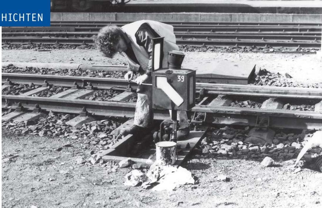
Zu den Aufgaben der Weichenreiniger zählte auch die Wartung von Petroleumlaternen, die mit Bürsten gereinigt und mit Petroleum aufgefüllt wurden. Bei elektrischer Beleuchtung entfiel das Befüllen.
