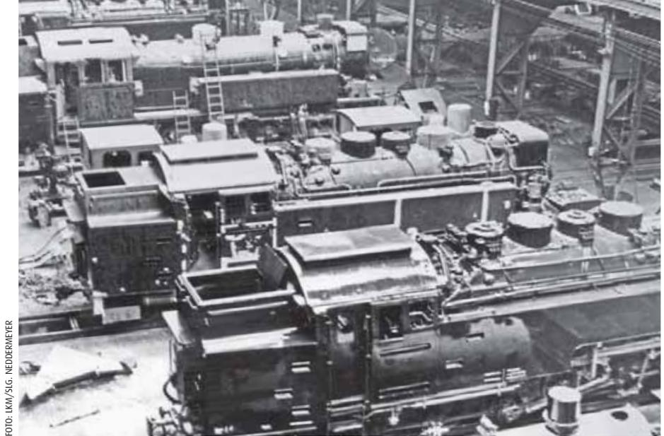
Zum Jahreswechsel 1954/55 war die Produktion der ersten Serie bei LKM weit fortgeschritten. Zwischen einigen 99<sup>23</sup> sind eine der ersten 83<sup>10</sup> sowie zwei 600-mm-Feldbahnloks erkennbar.
