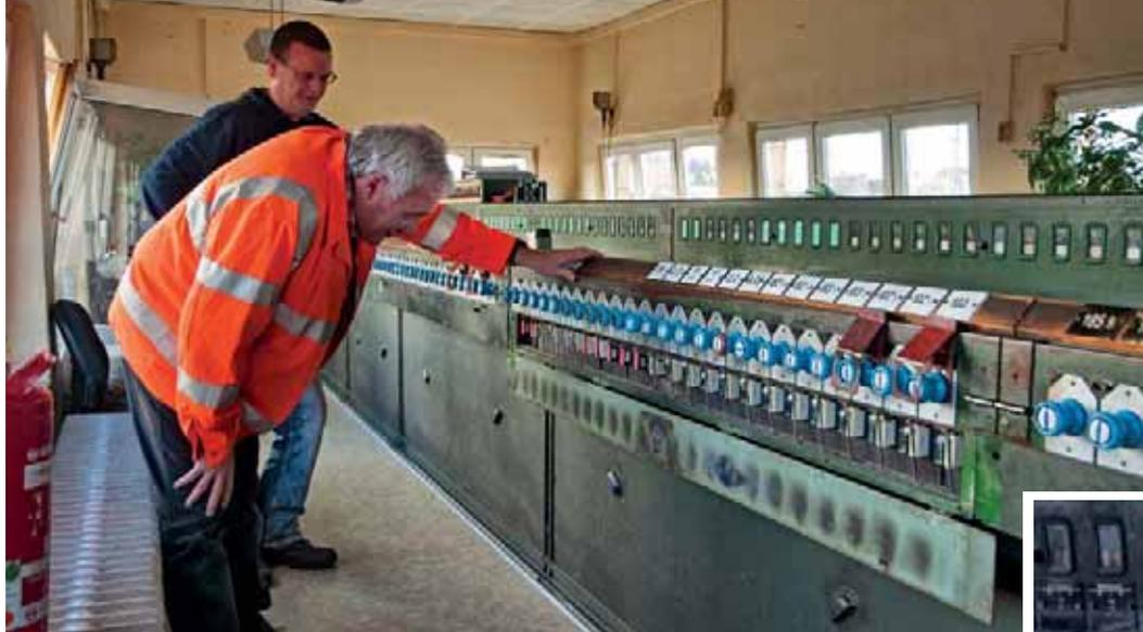
Die Hebelbank für die Westseite des Bahnhofs mit den blauen Weichenhebeln. Die geöffnete Klappe vor den Sicherungen zeigt durchgehend die mehr oder weniger kräftigen Spuren des Durchbrennens.
