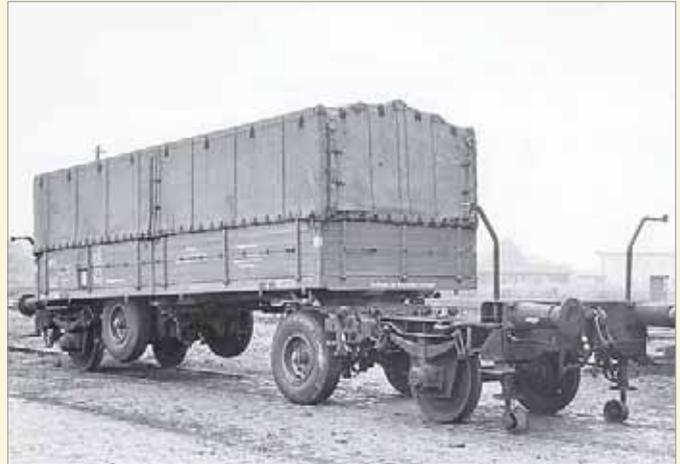
Das Umsetzen des Döttler-Owp 176 war umständlich. Die Straßenräder wurden hochgeklappt und die Schienenfahrgestelle untergeschoben.
