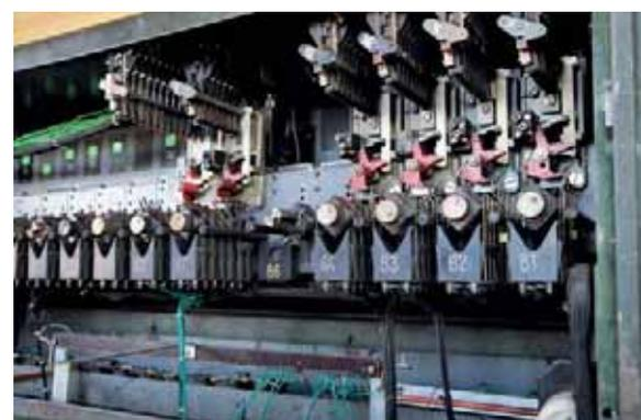
Die von befugter Hand geöffnete Rückseite zeigt die Weichen-Umschalt-einrichtungen.
