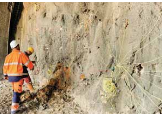
Die einzelnen Spengsätze werden verkabelt und für die Fernzündung vorbereitet.
