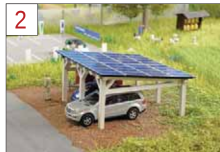
Zwei Pkw passen bequem unter das Schuttdach, das als kleines Kraftwerk dient.
