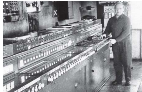
Im Inneren des elektromechanischen Stellwerks 0k war die Bauart E 43 eingebaut.
