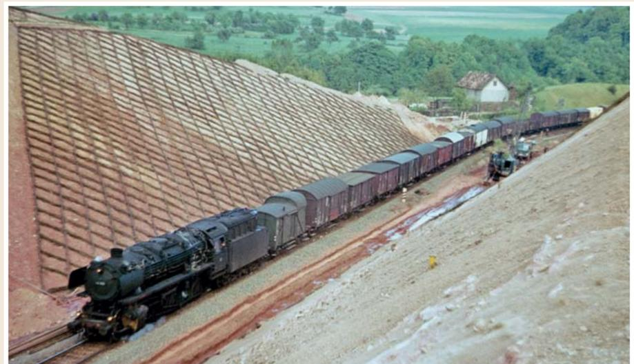
V 200 010 leistet einer 01 Vorspann vor einem D-Zug. Vor dem temporären Tunnelmund ist die Verschwenkung der baubedingt nur eingleisigen Strecke zu erkennen.
