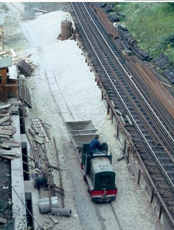
Von den Lagerflächen in den Tunnel liefen die Transporte mittels Feldbahn auf der Trasse des ausgebauten Richtungsgleises.
