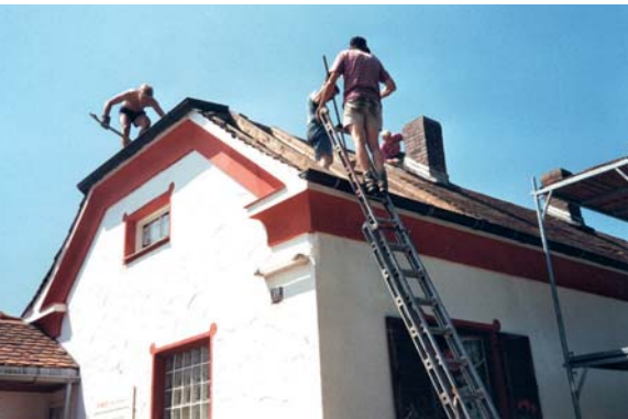
Alle helfen zusammen beim Dachdecken. 1994 spendierte die Stadt Immenstadt die Dachplatten fürs Gebäude in Hegge.
