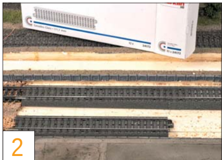
Zur Ausrichtung des neuen Gleismaterials, hier das C-Gleis von Märklin, bleiben die alten Bahnsteigkanten zunächst noch stehen.
