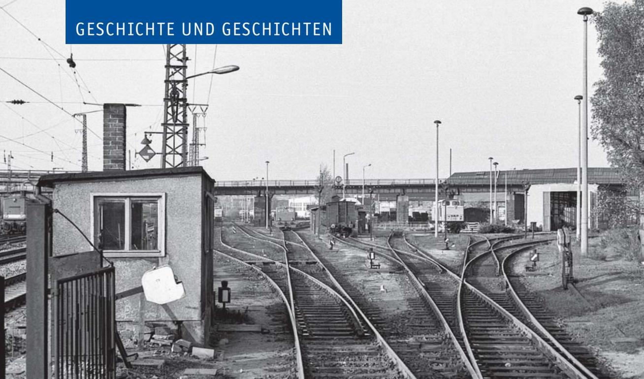
Ein Blick durch das Gleistor ins Gelände im Oktober 1989: rechts vor dem Verwaltungsgebäude der ehemalige Anheizstand, daneben die Drehscheibe mit einer 106. Dahinter überspannt die Brücke des Verbindungsbogens (RCCh-Linie) das 72 Hektar große Gelände.
