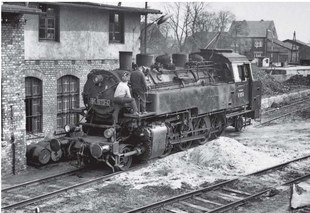
Kleinere Reparaturen führten die Eisenbahner der Est Gerbstedt selbst aus. Am 3. April 1976 wurde bei der 86 1573 ein Schaden am Oberflächenvorwärmer beseitigt. Für die obligatorischen Fristarbeiten wurden die Maschinen ab Sommer 1968 nach Röblingen überführt.
