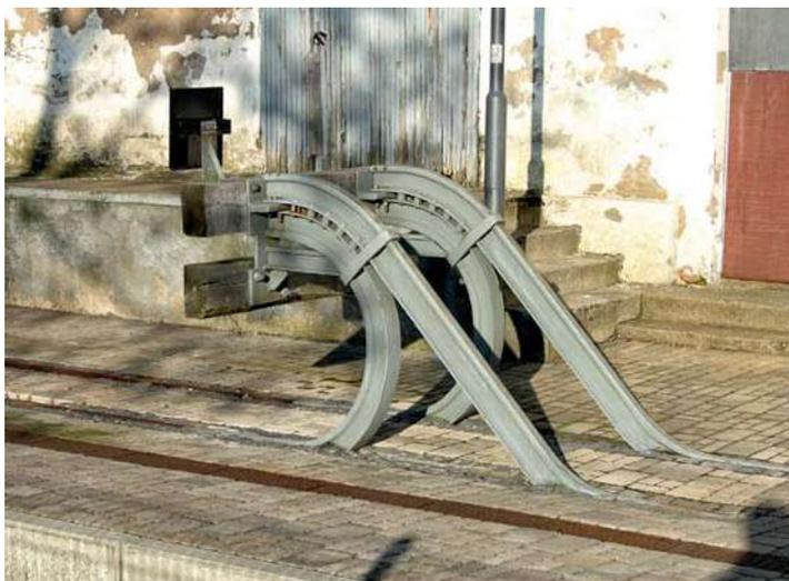
Die Rügische Bäderbahn verwendete bei der Sanierung von Bahnhöfen traditionsbewusst solche form-schönen Prellböcke aus gebogenen Schienenprofilen.
