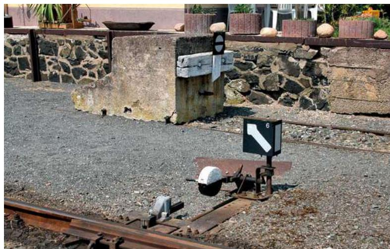
Auf dem Netz der Harzer Schmalspurbahnen befinden sich einige massiv ausgeführte Gleisabschlüsse aus Beton, so auch in Hasselfelde.
