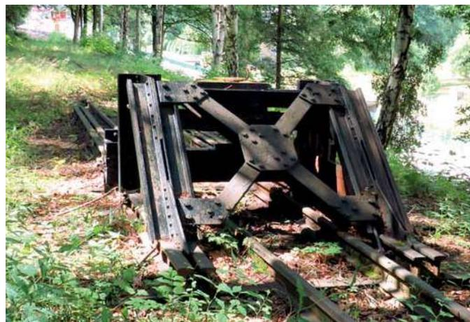
Rückseitig ist der Prellbock mit weiteren Schienenstücken, durch Knotenbleche verbunden, abgestützt und diagonal versteift.
