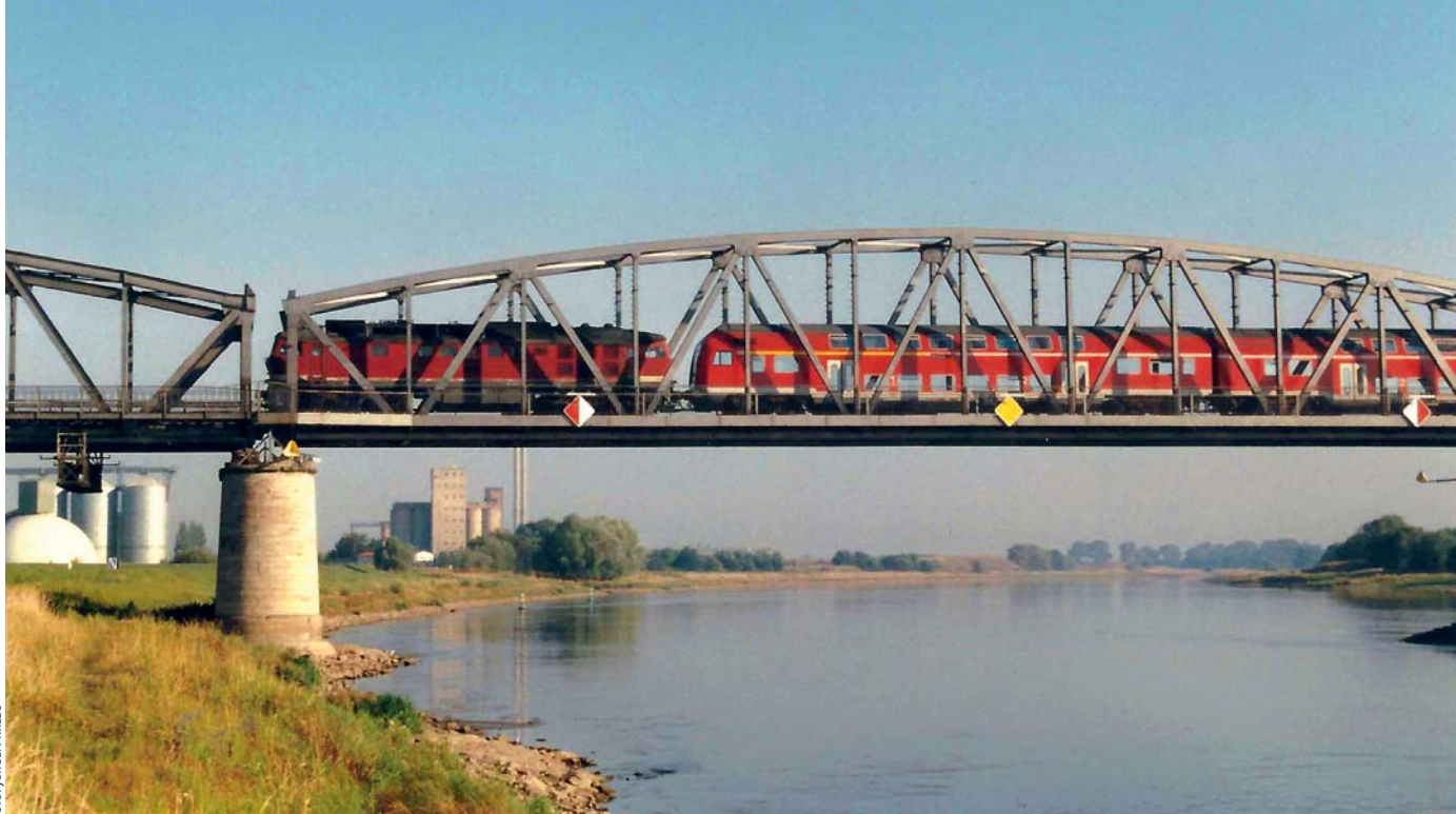
Die RB Berlin – Wernigerode befuhr 1999 die Brücke, deren Überbau 1976 neu errichtet worden war. Die Weizenstärkefabrik entstand nach 1990.
