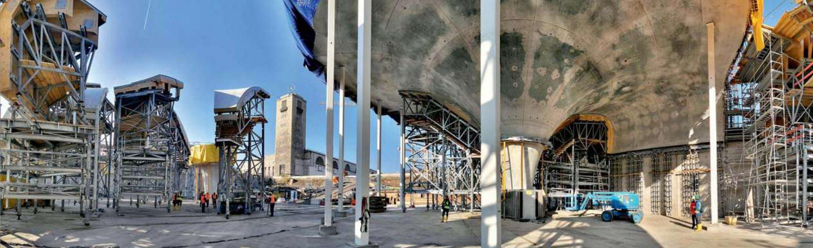
■ **Sichtbare Fortschritte beim umstrittenen Bahnprojekt Stuttgart 21:** Am 16. November 2018 wurde die erste Kelchstütze für das Dach des künftigen Hauptbahnhofs im Rohbau fertiggestellt. Ein eigens dafür entwickeltes Spezialfahrzeug
