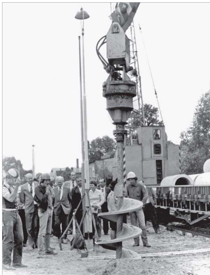
Die Mastfundamente werden mit Beton ausgegossen. Das Material wurde natürlich über die Schiene herbeigeschafft.
